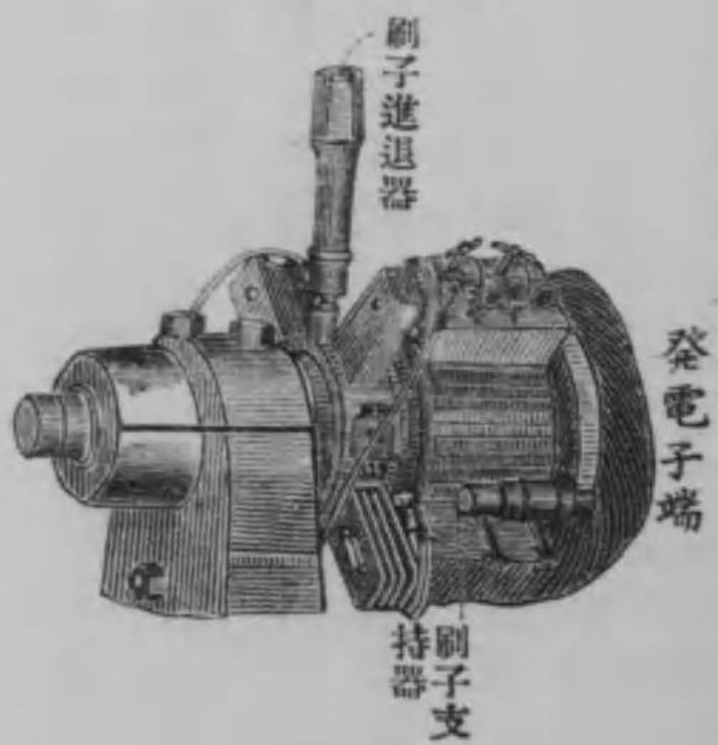
第三十九圖 發電子の整流子側の圖
