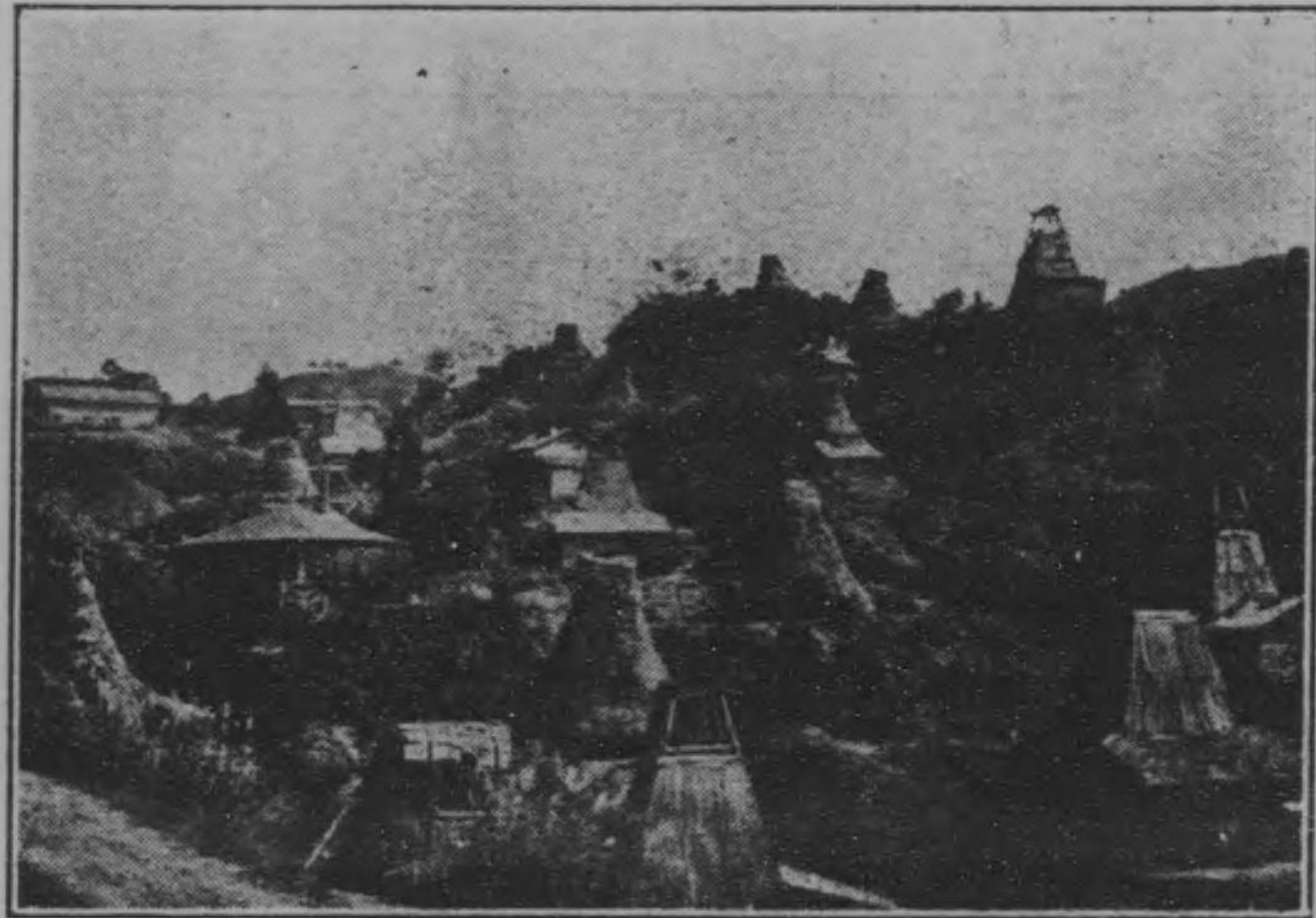
東山油田に於ける坑井式掘鑿の實景
