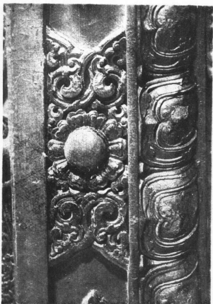
丙 保和殿寶座上枋
