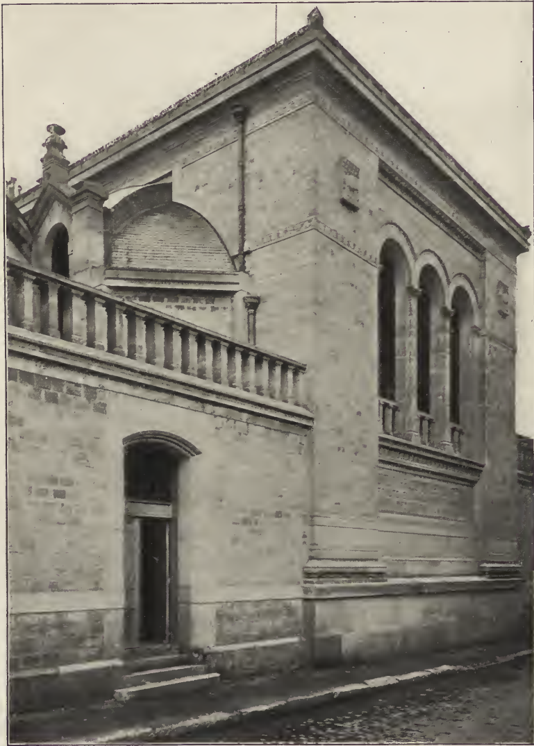
Fig. 2. ÉCOLE DE DROIT, PARIS. (Detail of New Building.)
