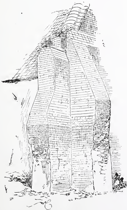
Contreforts de la grange d'Allaertshuizen.
