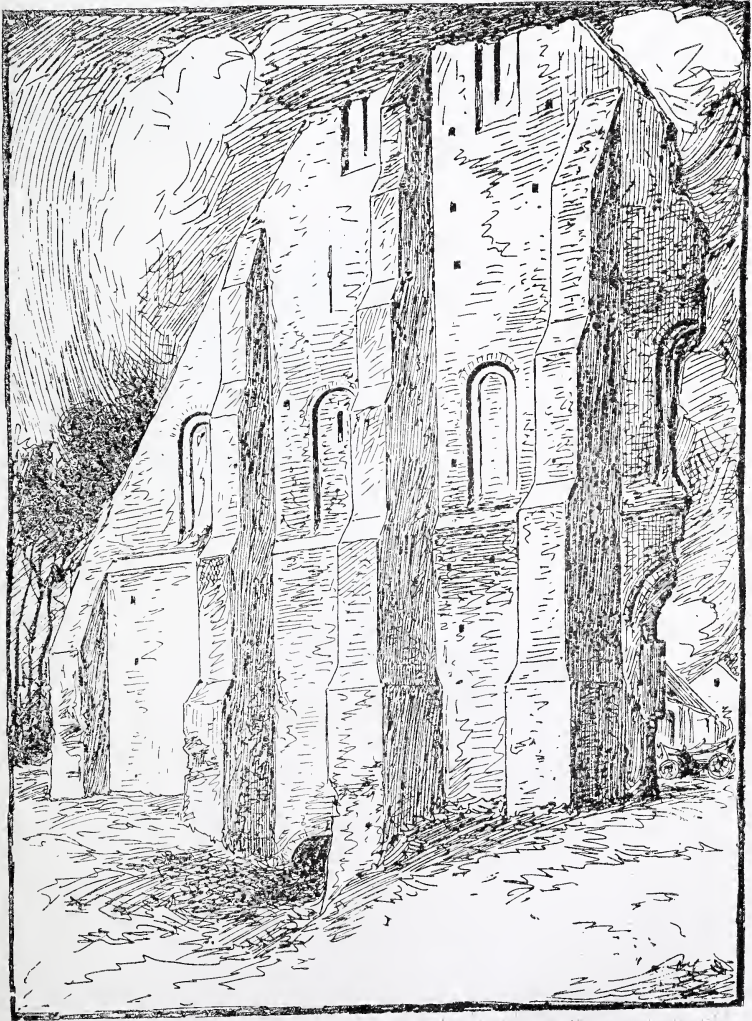
Le grand pignon de la grange d'Allaertshuizen.
