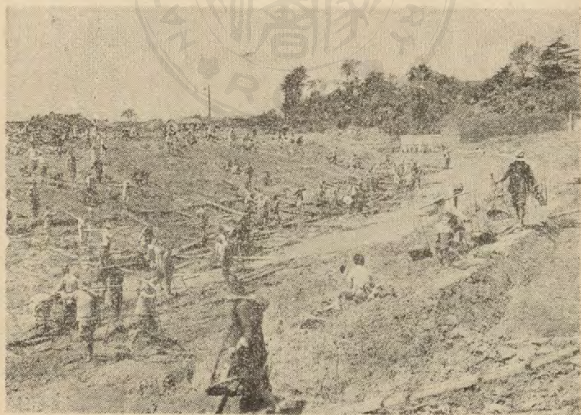
行總以工賑方式發動工人挖浚上海之徐家匯河
