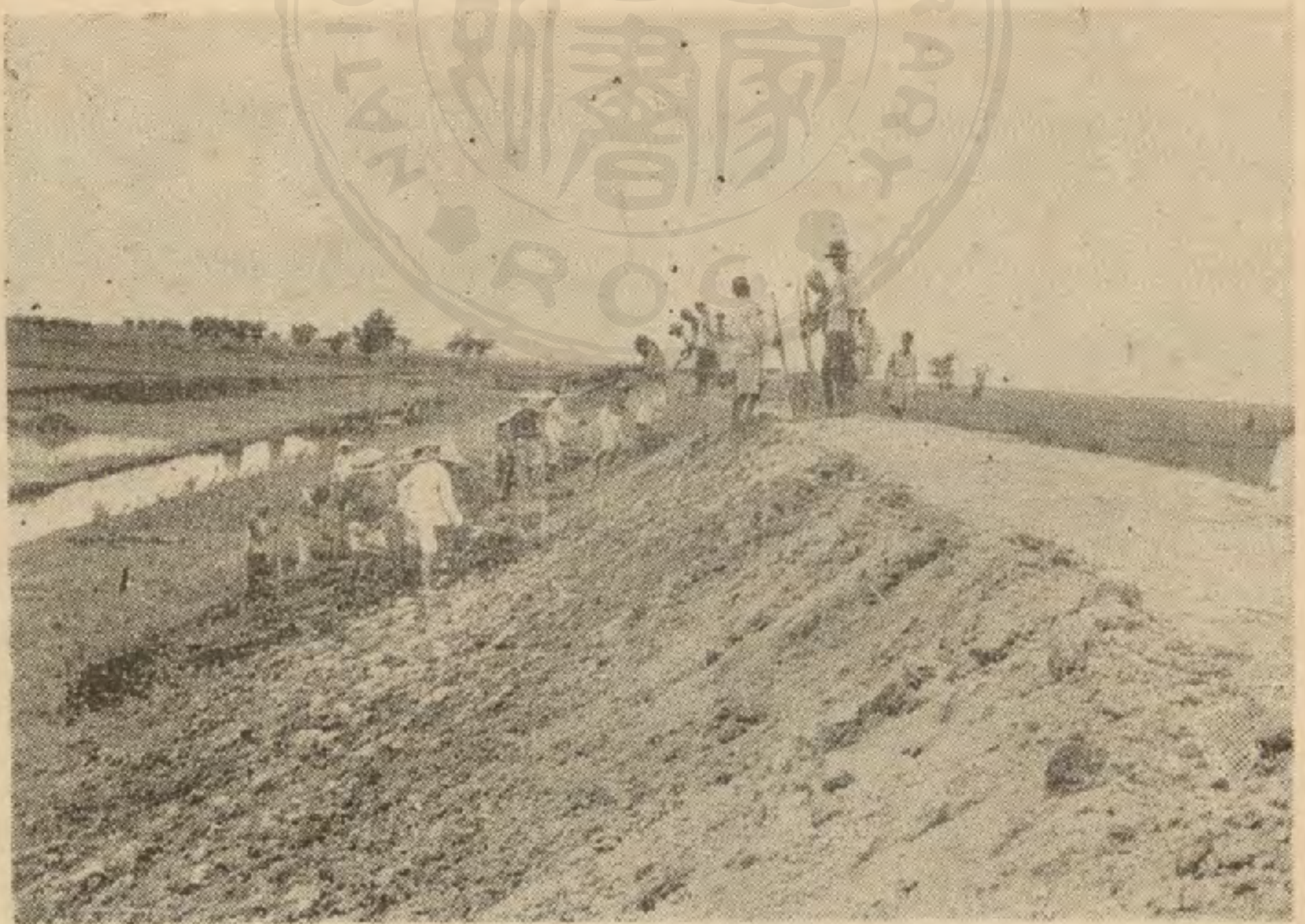
行總所雇工人在天津南端建築堤壩以防農田爲水所淹
