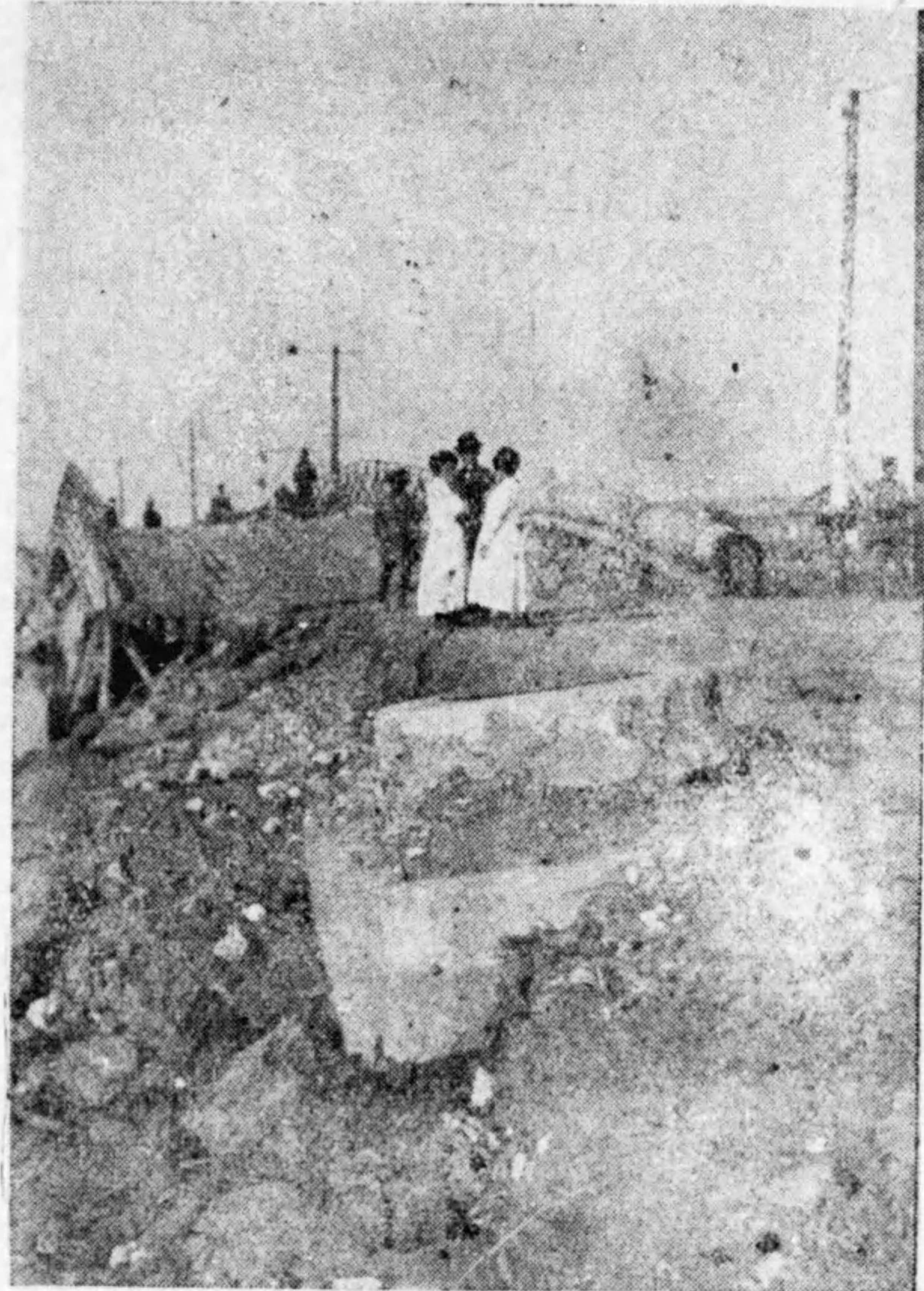
地下管路人孔の損破
