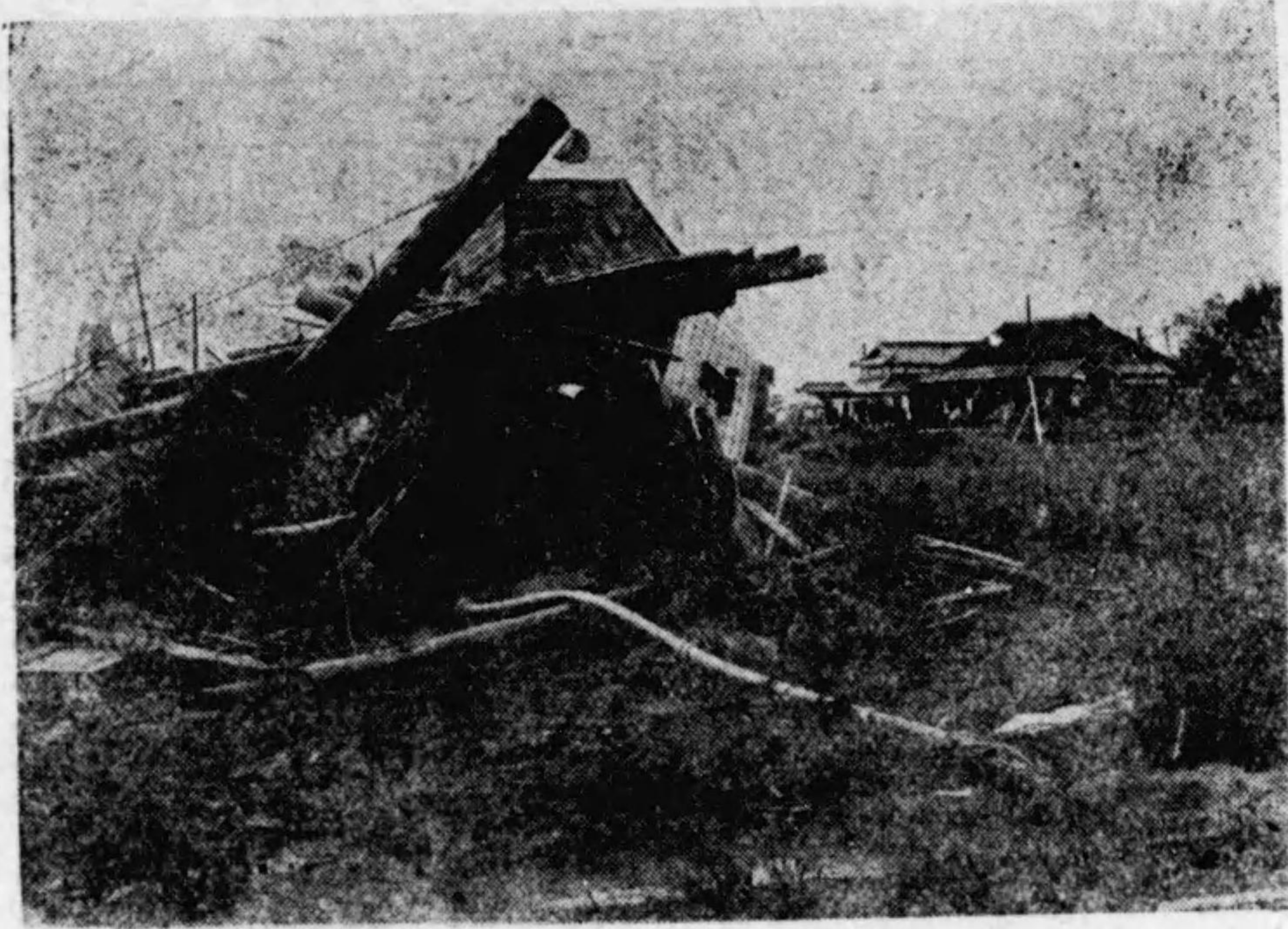
所箇斷切ルブーケ斜傾柱上引送川間百ルブーケ離距長島尾京市山岡
