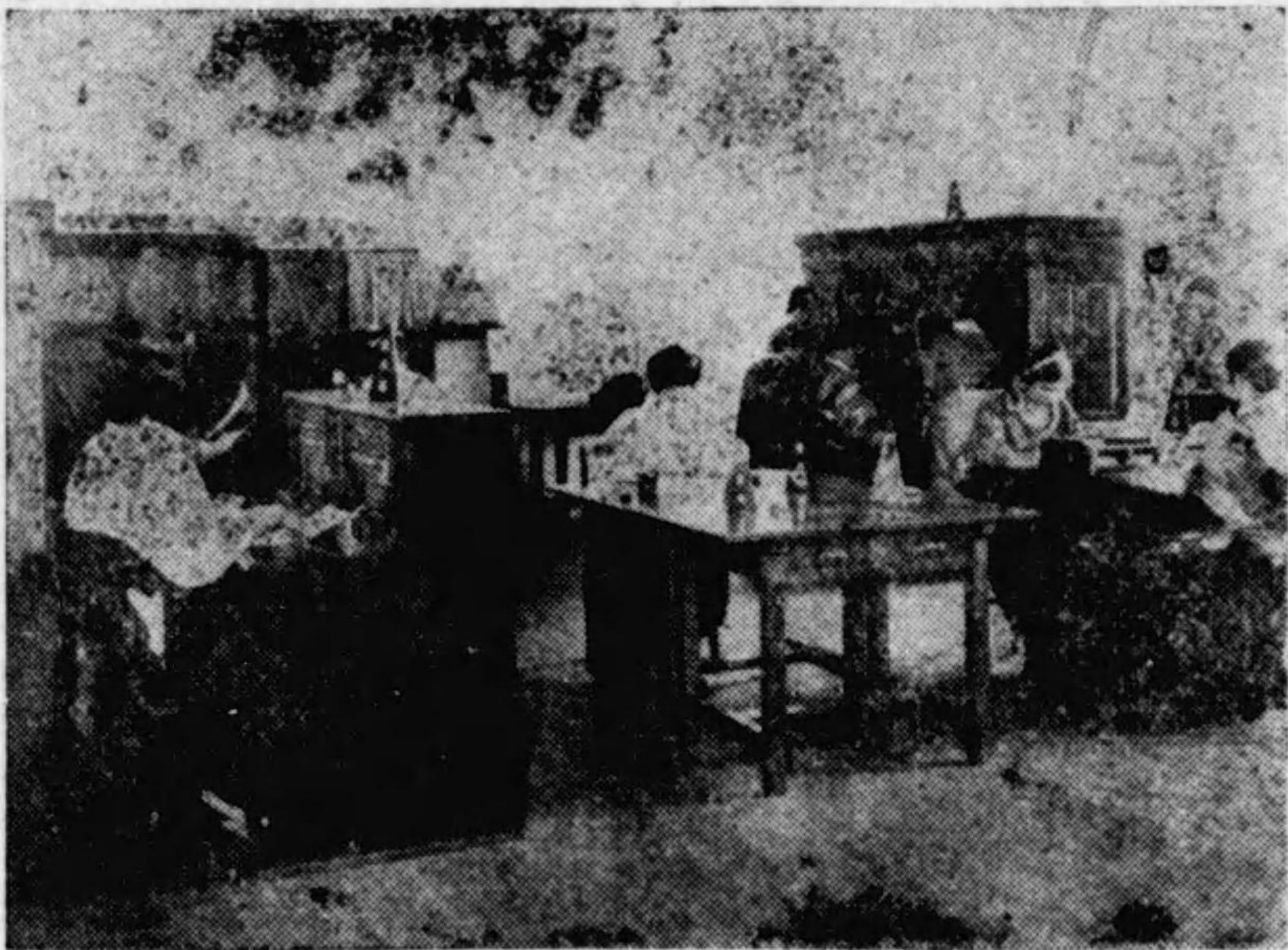
市外交換實習状況
