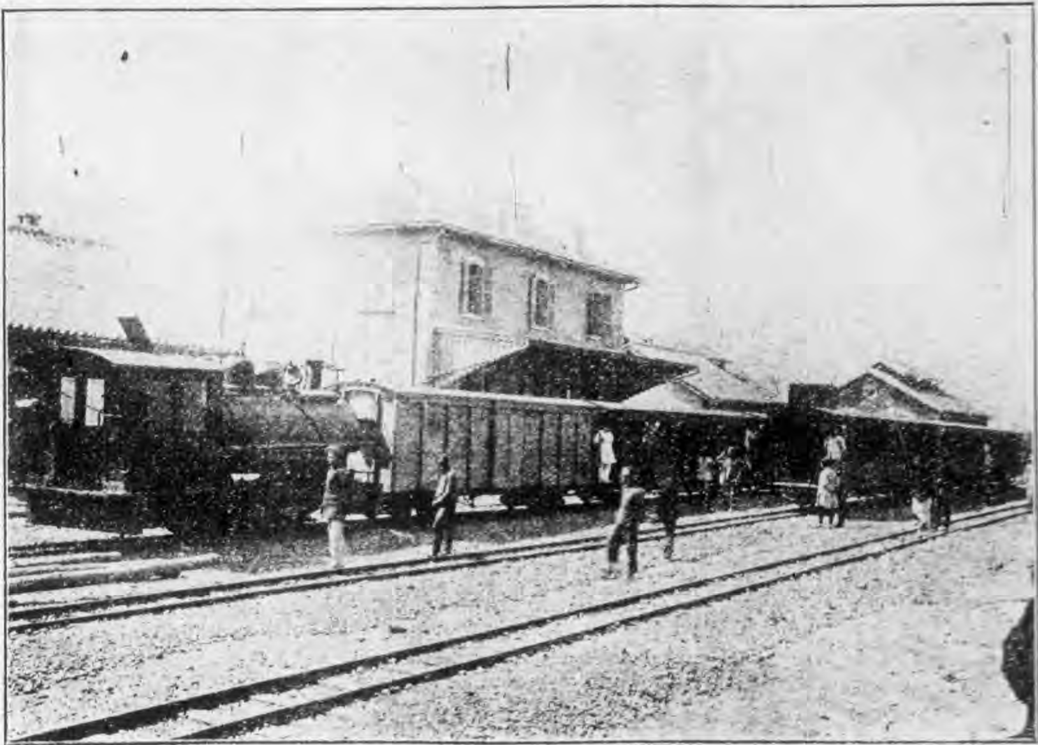
雲南簡碧鐵路蒙自車站之一部
