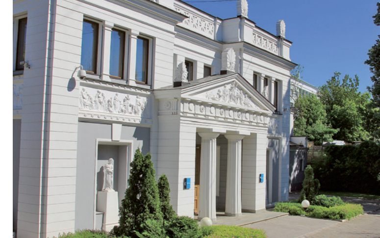
Здание бывшей «Станции ботанического сада Императорского общества акклиматизации животных и растений» на Конюшковской улице. Фото автора. 2020 год.
