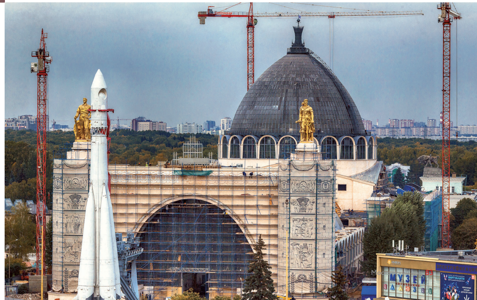
Ремонтно-реставрационные работы в павильоне «Космос», октябрь 2017 года. Департамент общественных связей ВДНХ.
