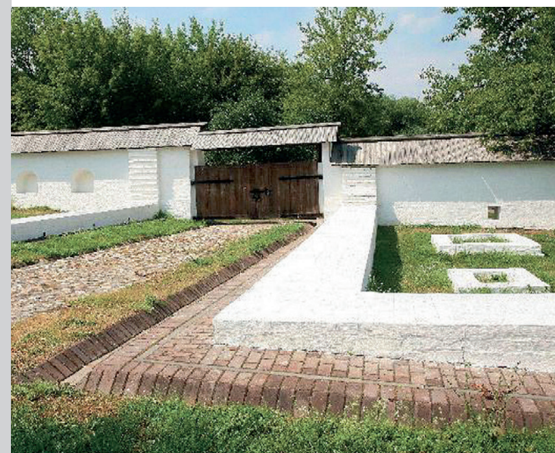
Коломенское. Основание фундаментов Кормового двора.
