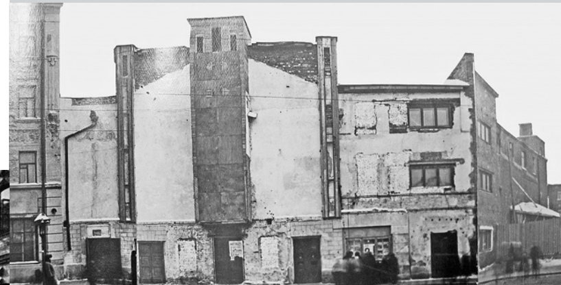
Фасад кинотеатра «Гранд-плезир» («Баррикады»). Фрагмент фотопанорамы нечетной стороны Баррикадной ул. 1932 год (архив Мосгорнаследия).
