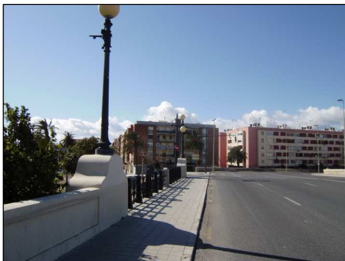
Puente de Astilleros
