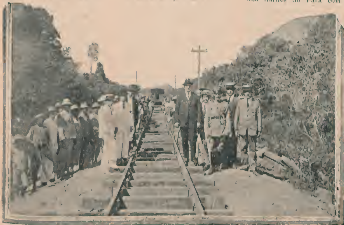
O governador Dionysio Bentes acompanhado por sua comitiva e pelo engenheiro Crespo de Castro, inspecionam um trecho reconstruido da Estrada de Bragança
