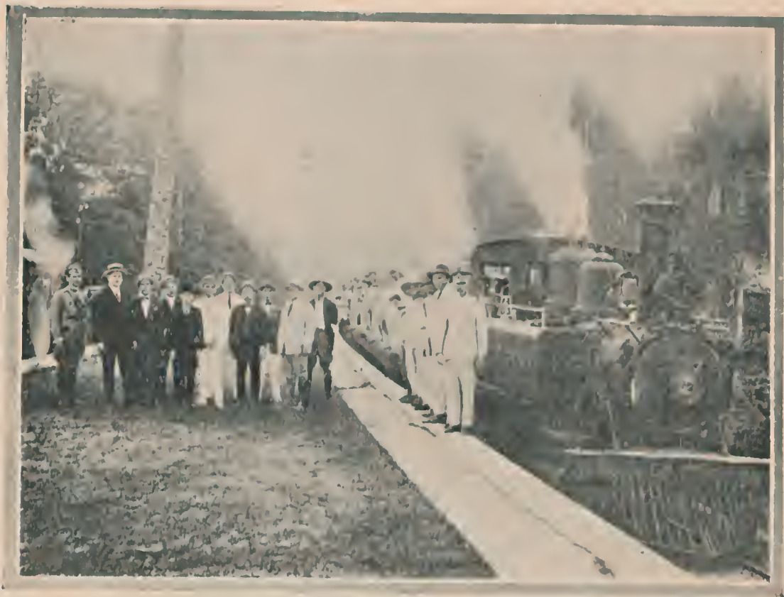
Na Estação de Entrancamento — O governador parense em viagem de inspecção dos trabalhos de reconstrução da Estrada de Bragança.
