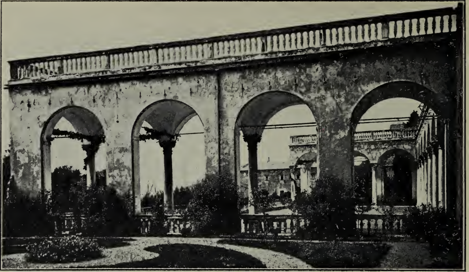
Abb. 55. Säulenhalle des Palazzo Doria.
