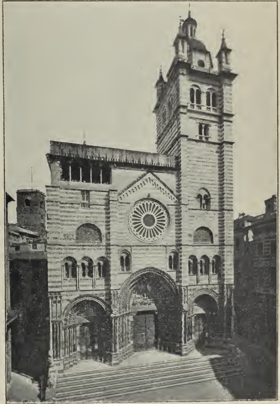
Abb. 7. Fassade des Doms S. Lorenzo.
