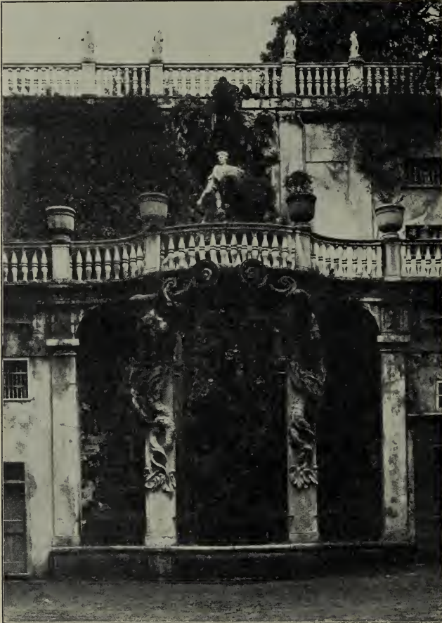
Abb. 86. Filippo Parodi, Brunnengrotte im Hofe des Palazzo Raggio-Podestà.
