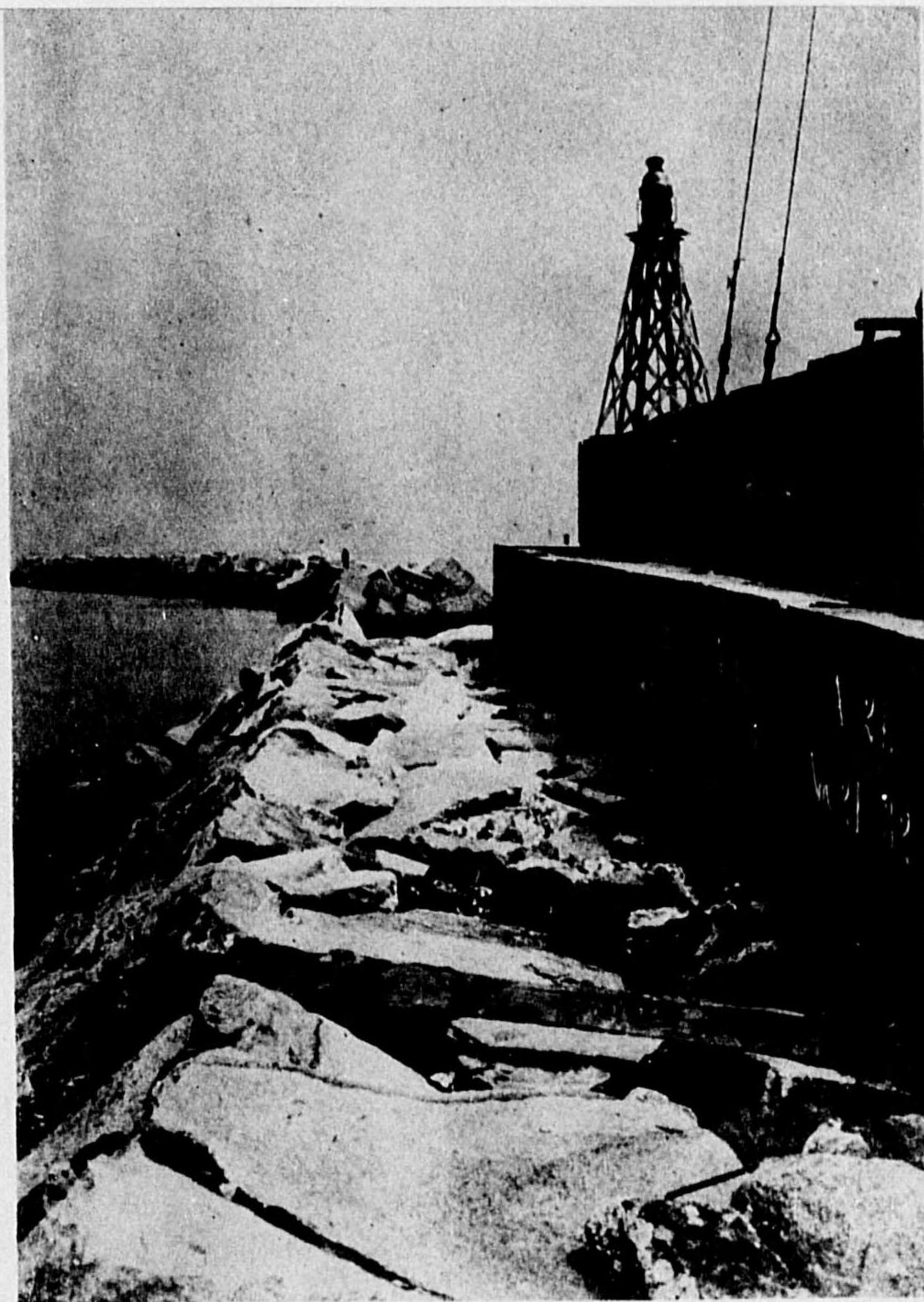
大阪港工事内の堤捨石
