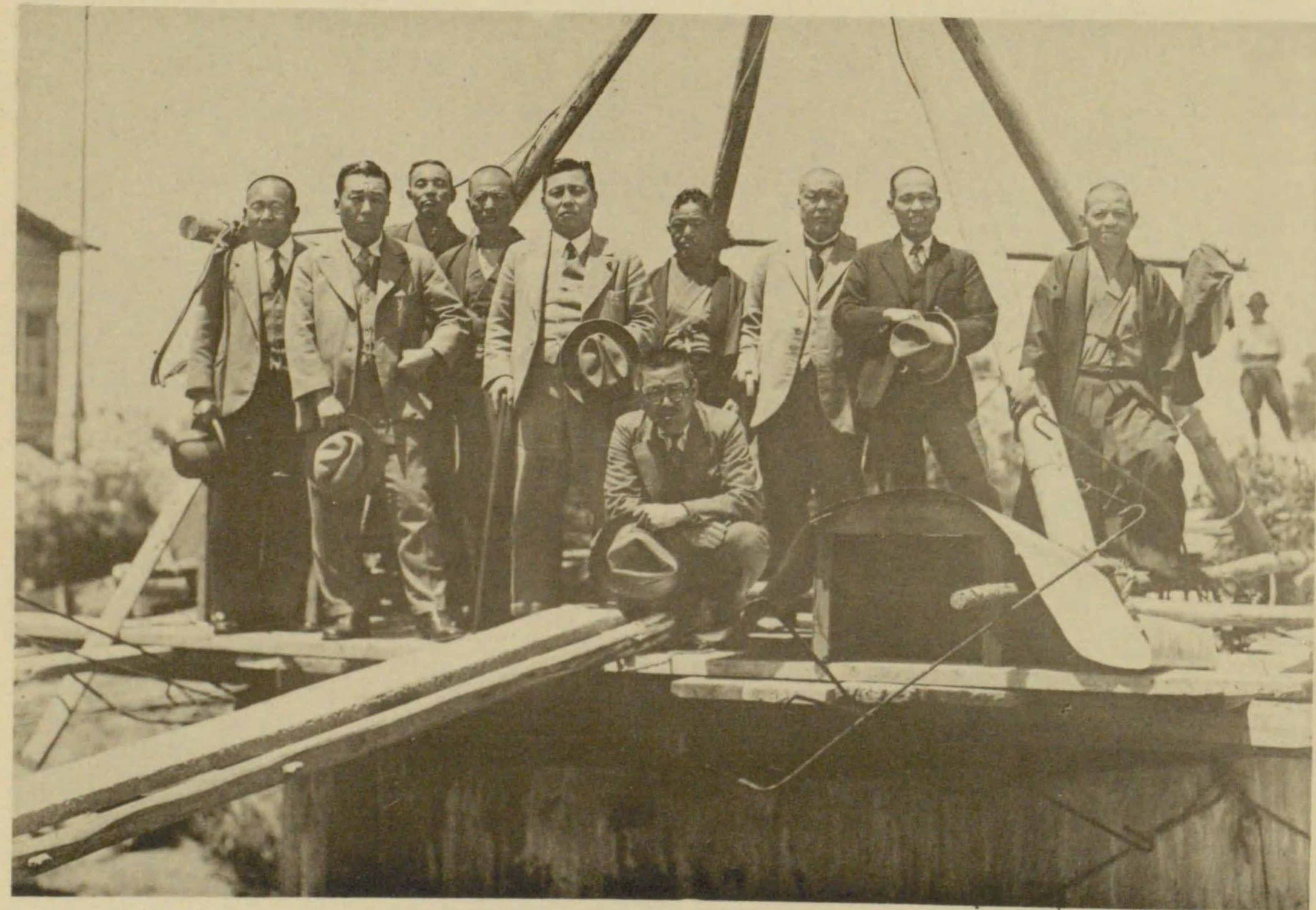
昭和十年五月二十三日水道委員水源工事視察
