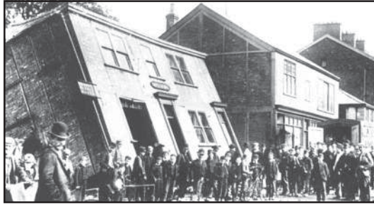
Рис. 1. Чилі. Осідання поверхні міста від гірничих робіт
