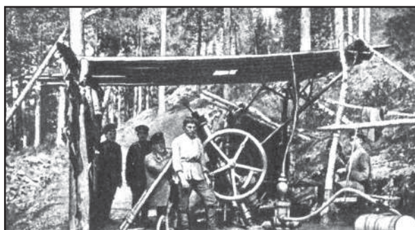
Рис. 6. Росія. Буріння розвідувальної свердловини на уральському залізорудному родовищі (фото XIX ст.)
