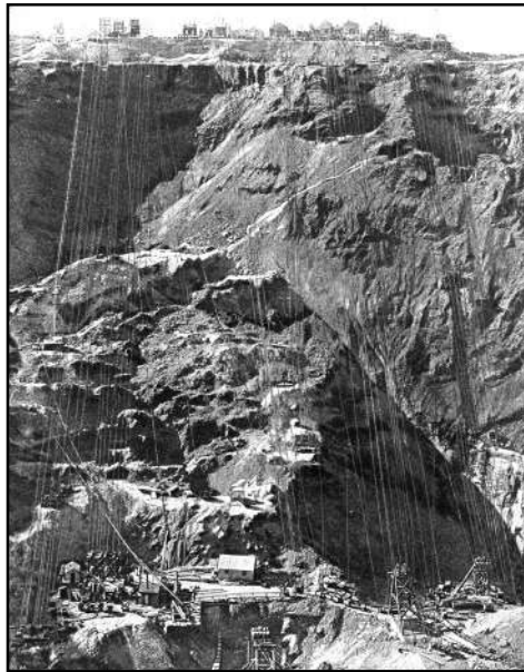
Рис. 2. ПАР. Котлованна розробка кімберлітової трубки (фото 1880 р.)
