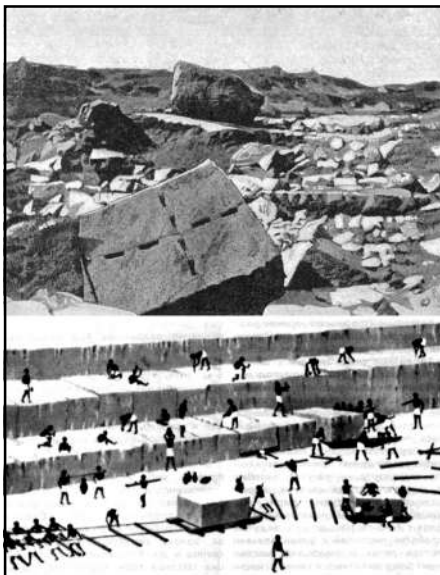
Рис. 1. Єгипет. Древня каменярня поблизу Асуана (фото кінця XIX ст.) та технологія розробки блоків (реконструкція)
