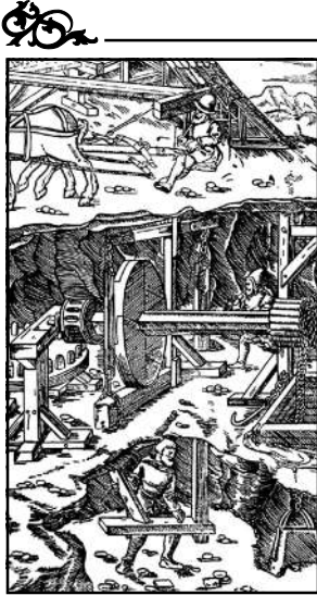
Рис. 7. Німеччина. Шахтний підіймальний механізм (за Г.Азріколою, 1556 р.)
