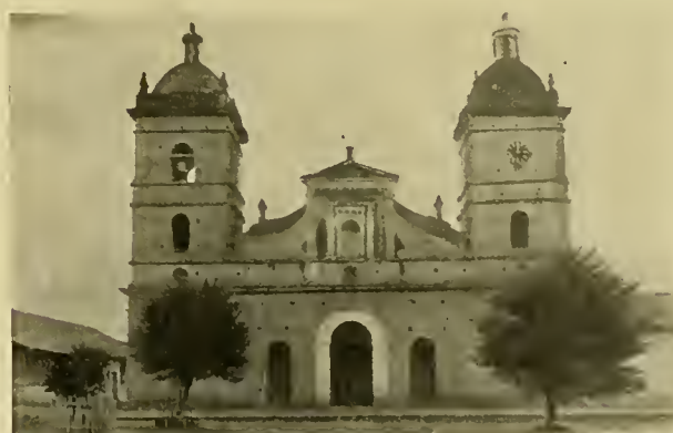
Frente de la iglesia—Front of Church
