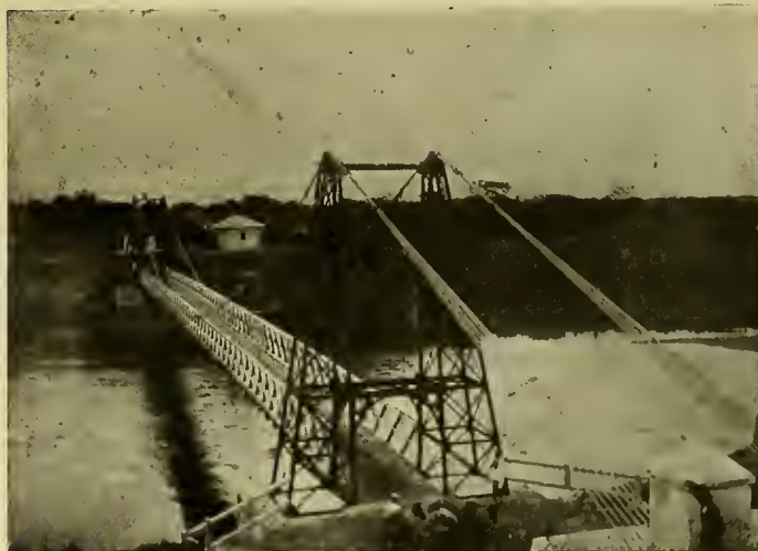
Puente sobre el Saldaña—Bridge over the Saldaña River
