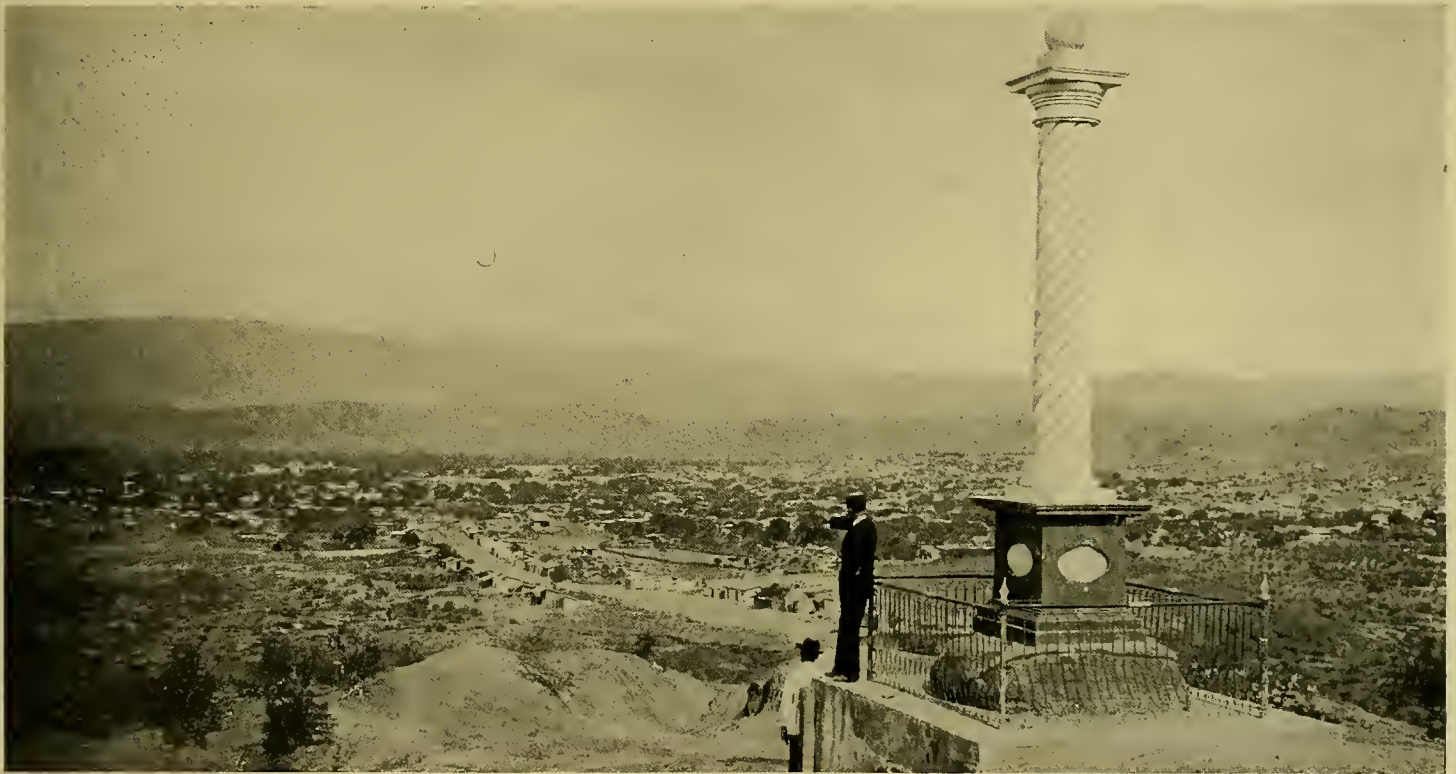
Columna de Bolívar—Bolívar Column
