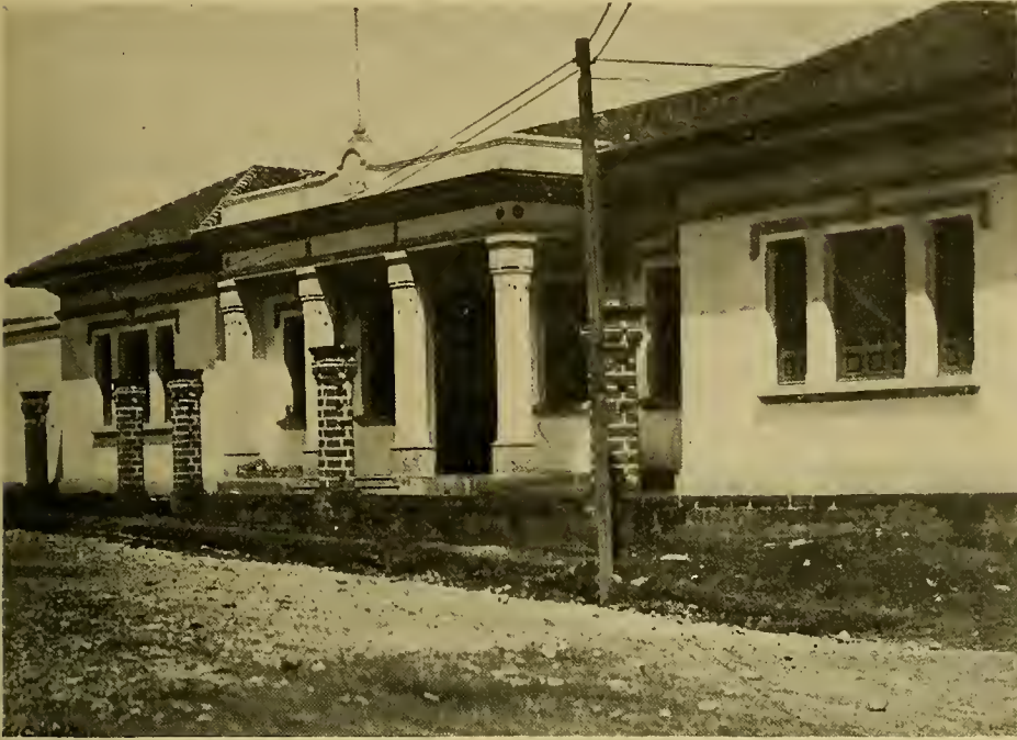
Escuela primaria (en construcción)—Primary school now building.
