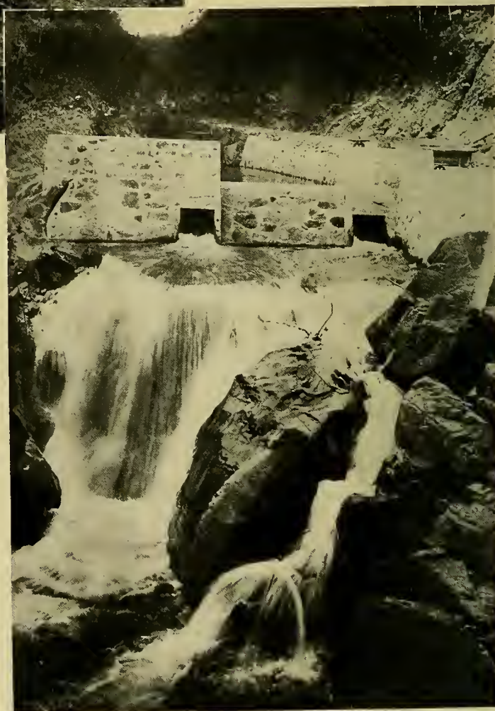
Toma del agua de Piedrasblancas—Piedrasblancas Water-Supply Intake.
