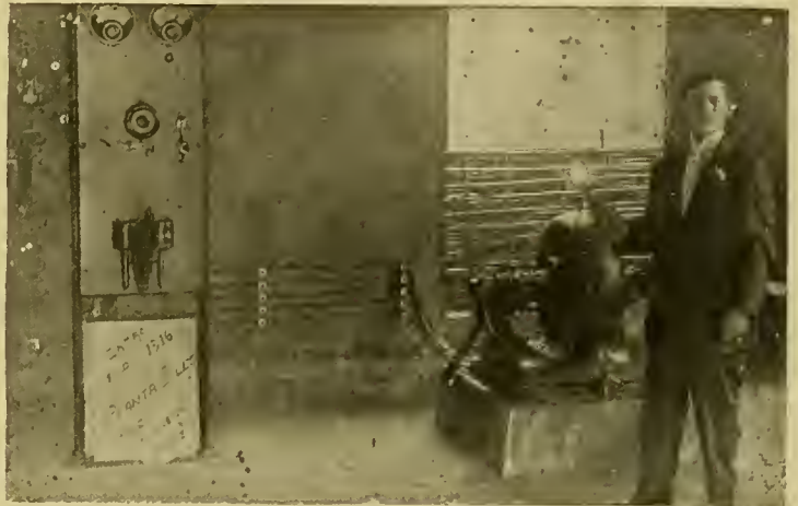
Planta eléctrica—Electric Plant
