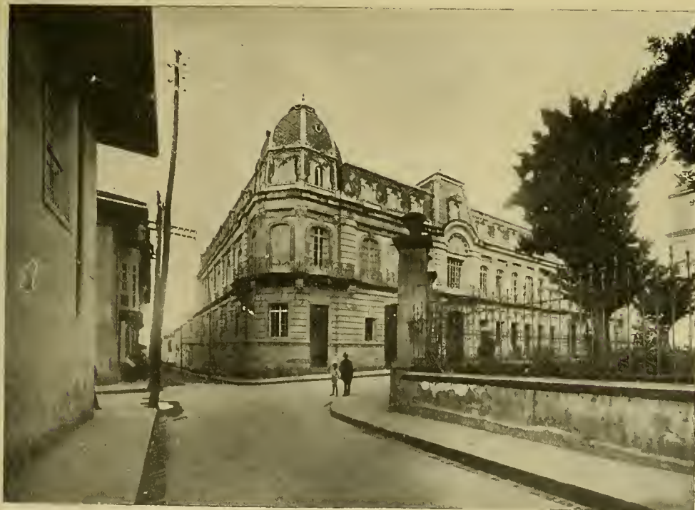
Edificio de Echeverri Hnos.—Echeverri Bros. Building
