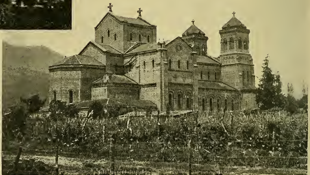
Catedral nueva en construcción—New cathedral now building.
