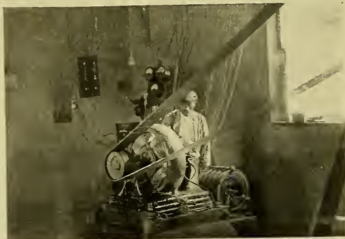
Planta eléctrica de Zapatoca—Zapatoca Electric Plant
