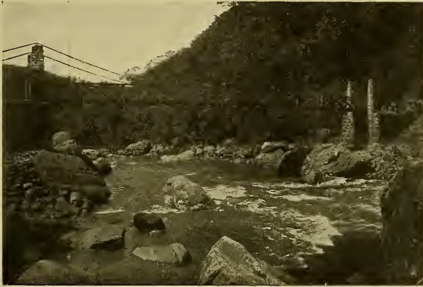
Puente sobre el Pajarito—Bridge over the Pajarito River
