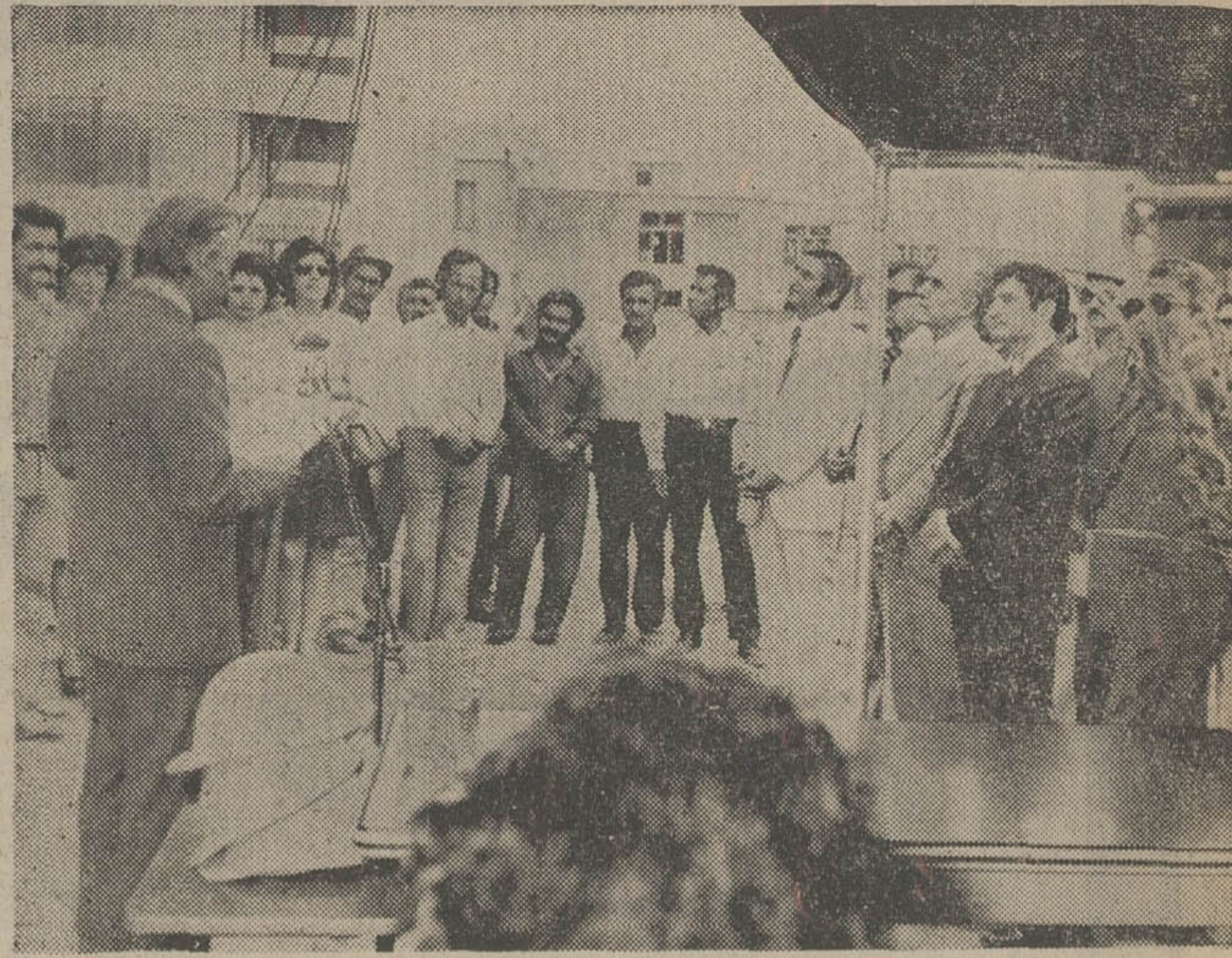
آقای مهندس کمالی مدیر عامل شرکت رانگین درباره مشخصات پل توضیحاتی برای اطلاع آقای شهردار پایتخت و همراهان بااطلاع رسانید
