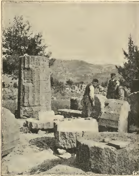
Abb. 7. Vorrichtung der Trommeln für die Ausflickung.
