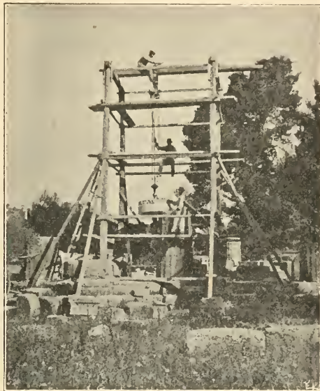
Abb. 6. Das Gerüst um die Ostsäule.
