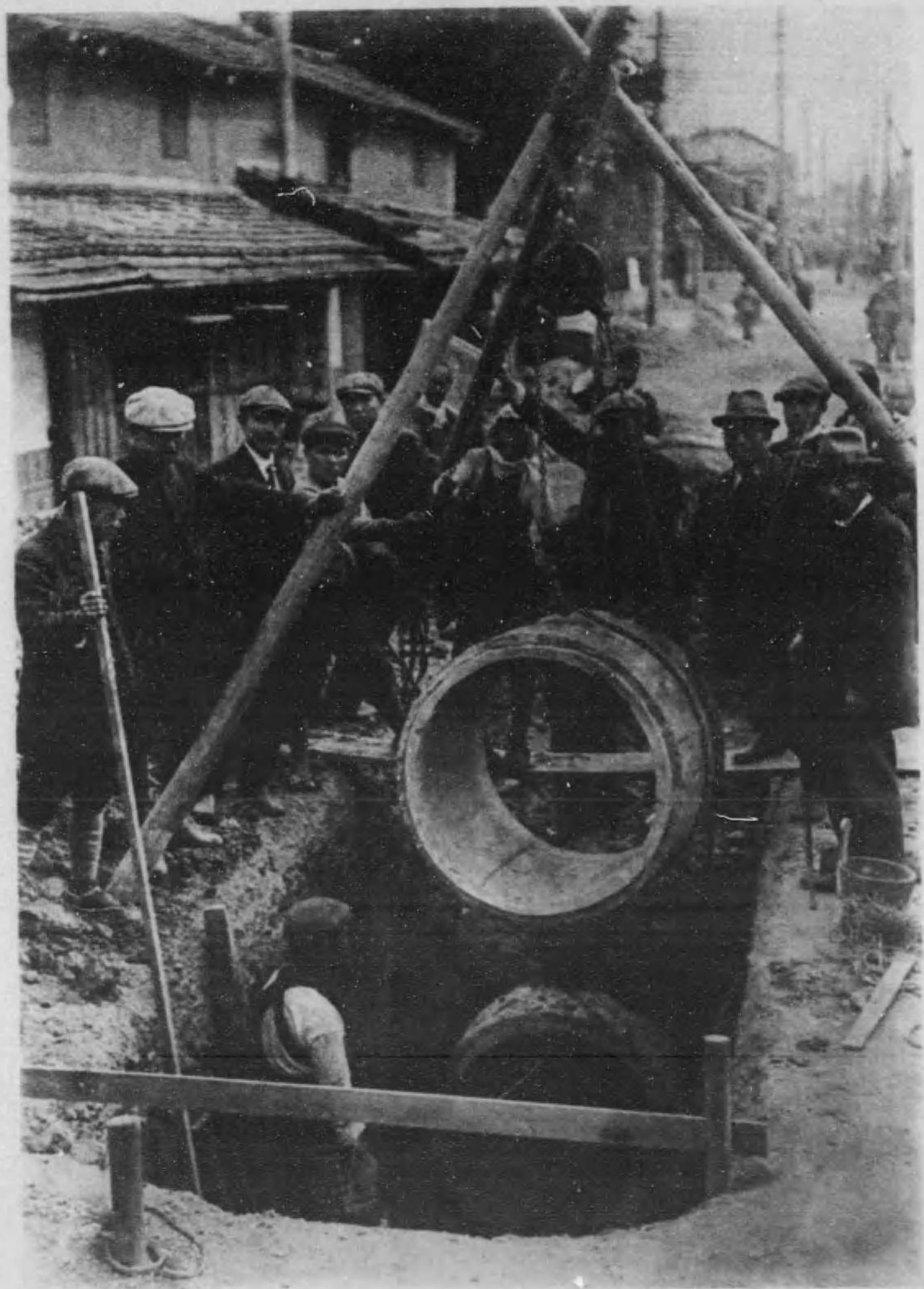
場現之設埋管トーリクゾ筋鐵尺參徑内
