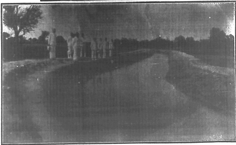
五、齊東青城交界馬鬮子廿一吋虹吸管工程引道水狀況
