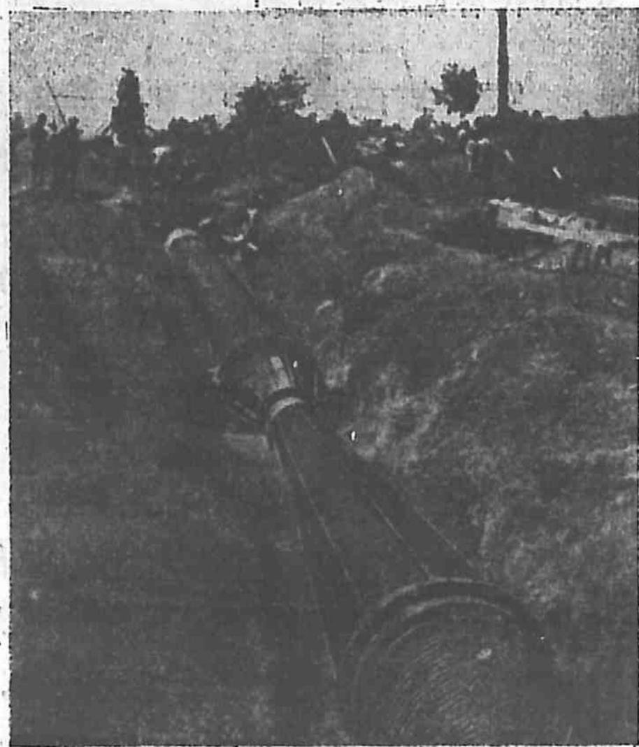
圖 81 在水管線中的細腰流量計
