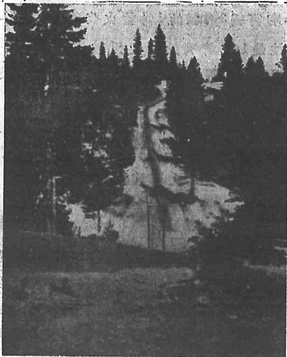
圖 133 接合鋼虹吸管.太平洋電氣公司之斯波爾丁湖的水管工程.
