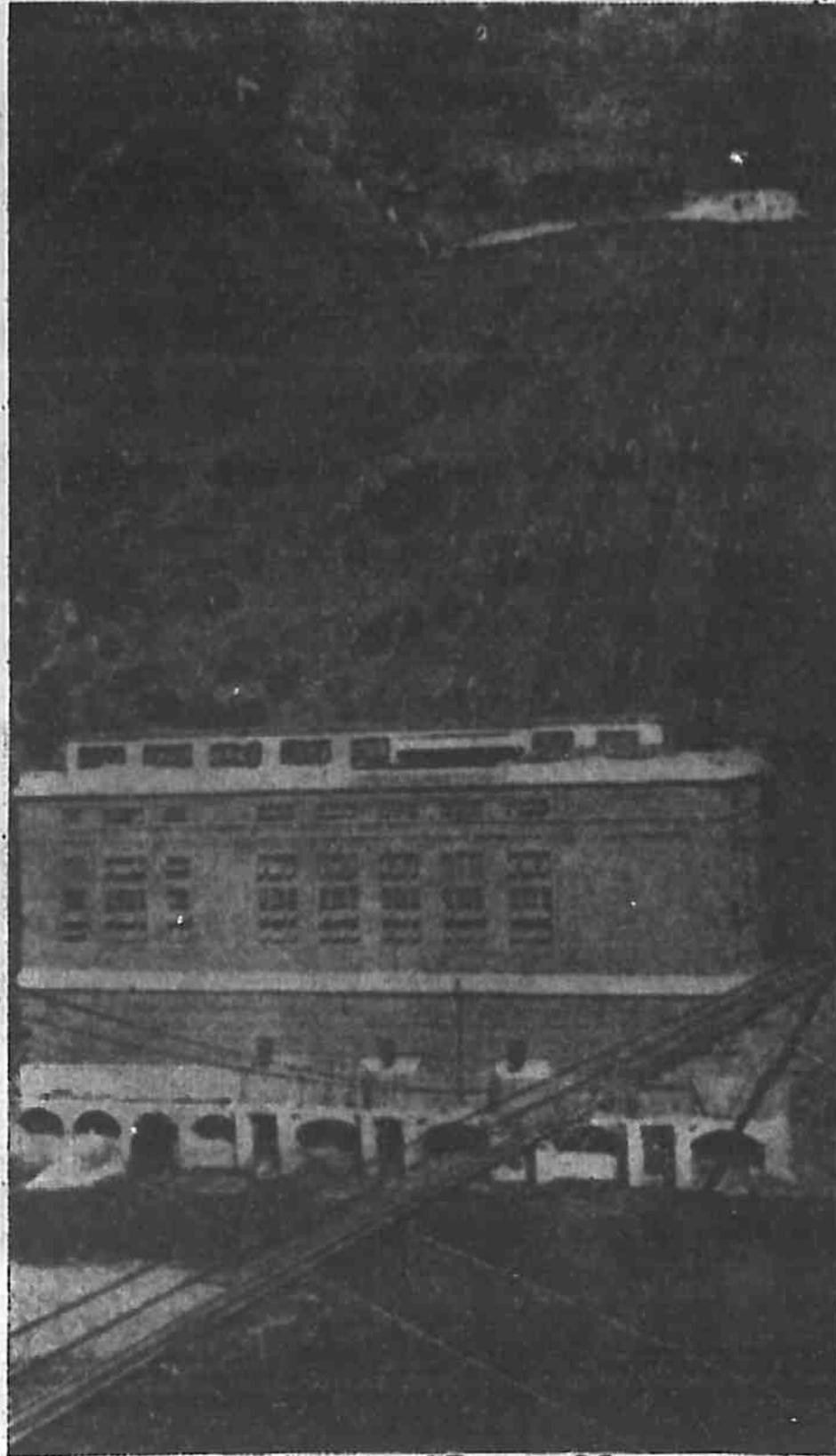
圖 208 在加利福尼亞聖河大灣之拉斯普魯姆斯力廠，有六個 18,000 馬力的反作用輪機，各在 465 呎水頭之下運轉。
