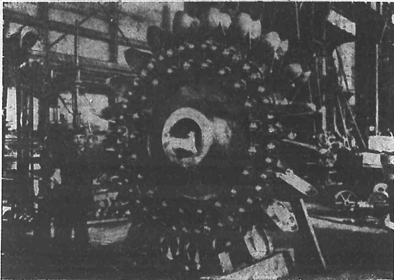
圖 172 太平洋電燈電力公司 (Pacific Light & Power Co.) 所用之亞利斯克查爾麥茲 (Allis-Chalmers) 衝動水輪.
