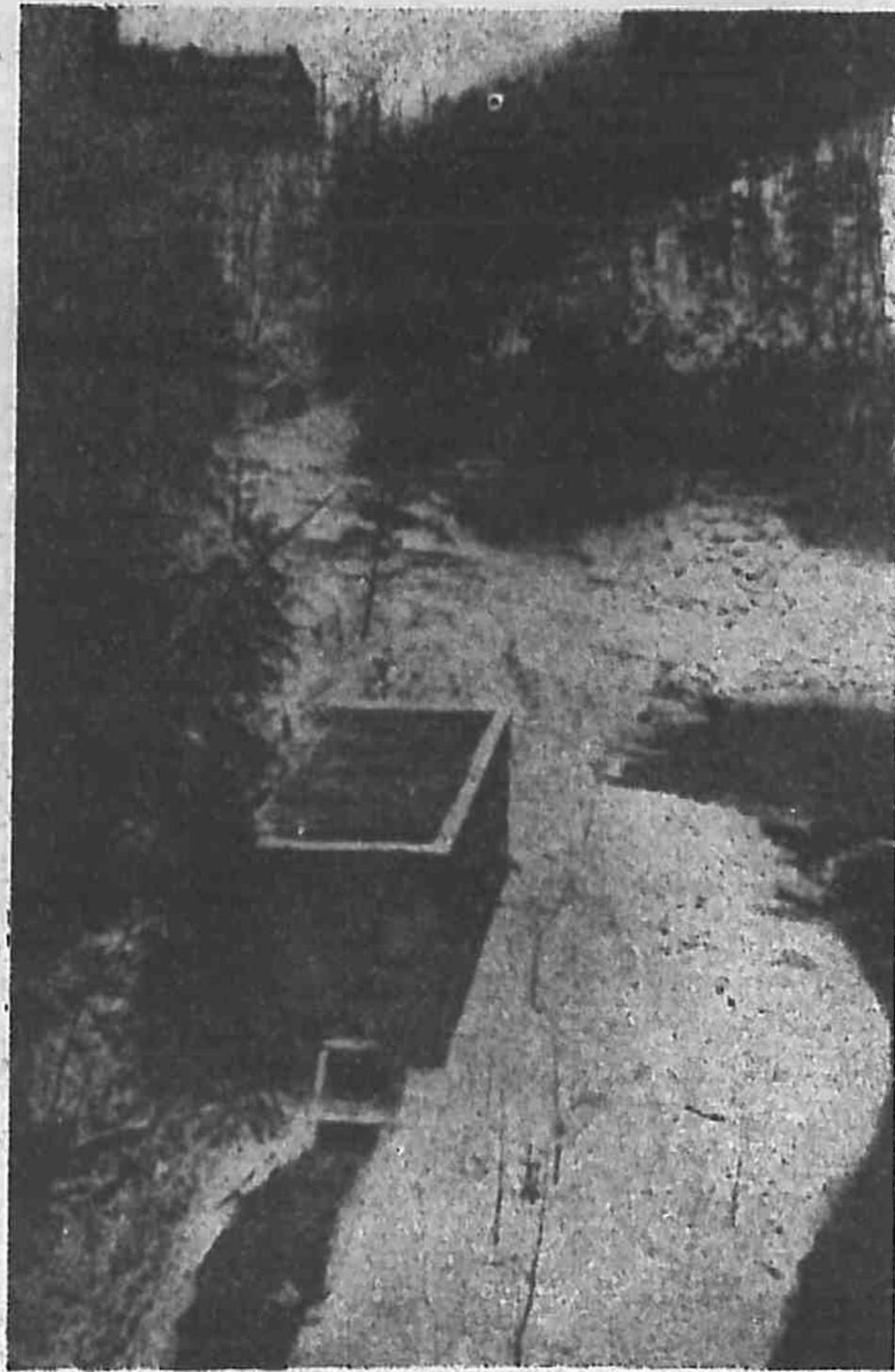
圖 210 科內爾大學之水電廠。水頭=140 呎，一個 550 馬力輪機，兩個 280 馬力的衝動輪和兩個 50 馬力的衝動輪。
