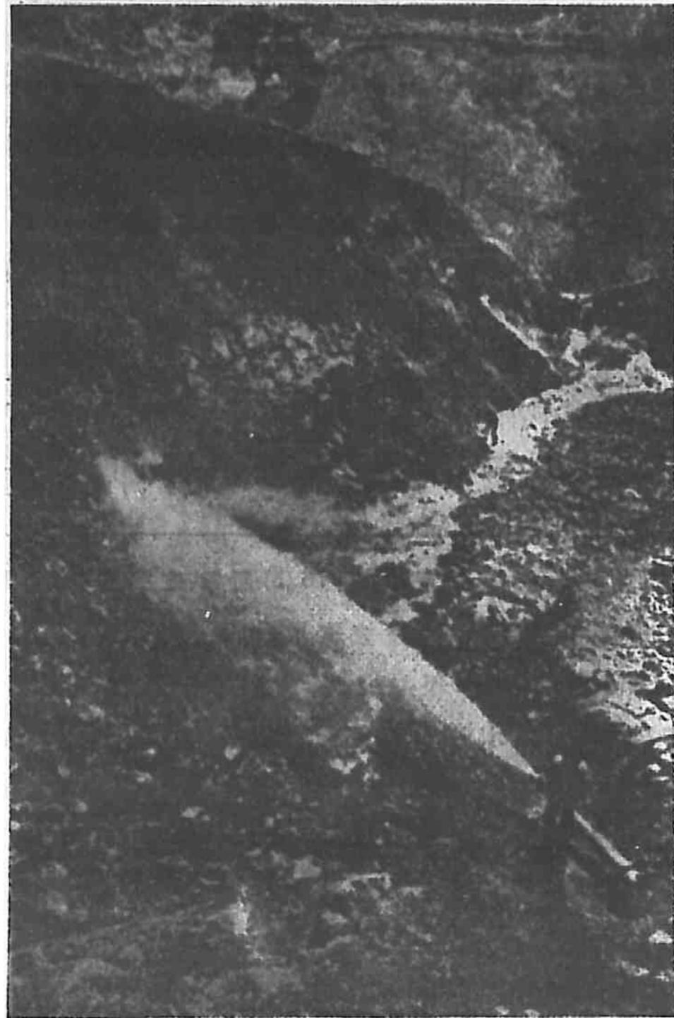
圖 78 從一大水管噴出的水注, 用作衝刷堤材料之土。
