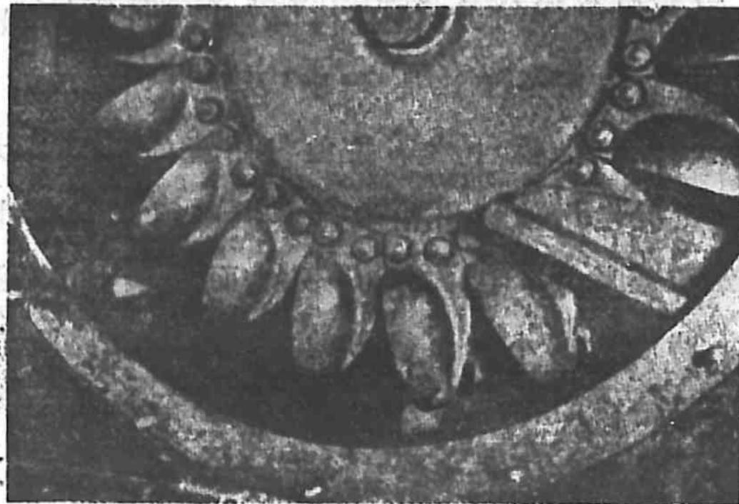
圖 167 含針管嘴的衝動輪(針碰曳後,管嘴敞開).
