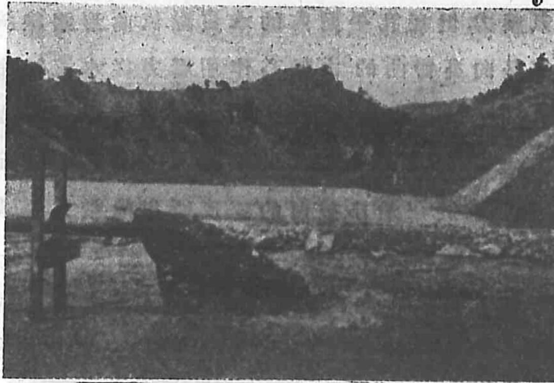
圖 69 建築卡拉米拉斯土堤的水、泥、及石塊的混合物，從一直管端放出。
