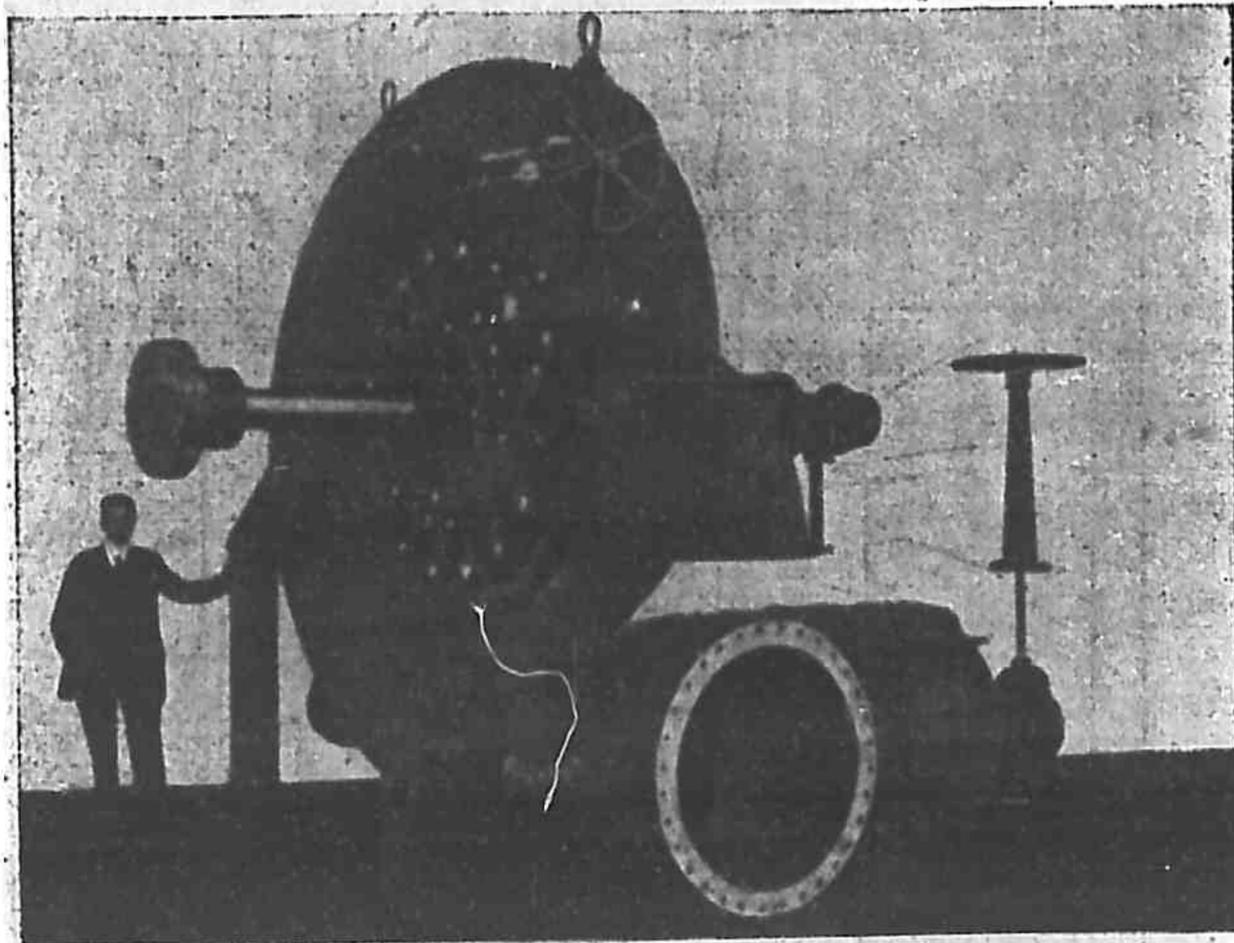
圖 181 螺旋形箱輪機，示出主要的門形滑門，導葉的移動環和鏈，及排水臂。
