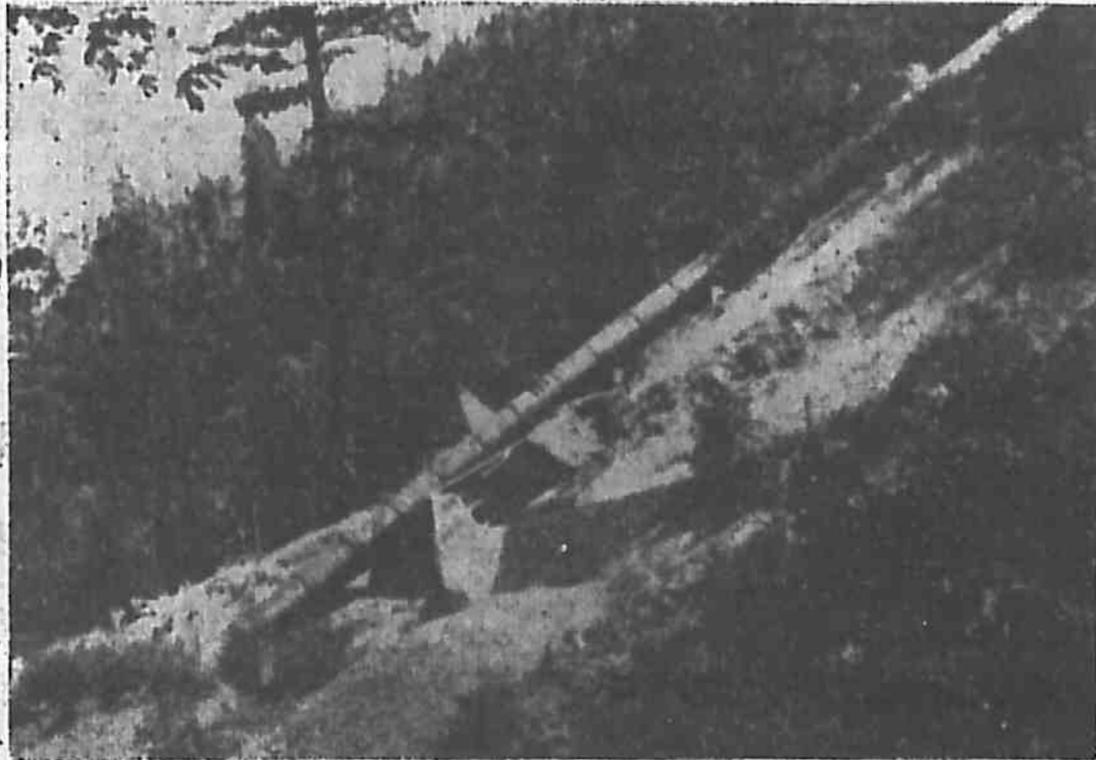
圖 124 在 1,300 呎水頭下的鉚合鋼管，引水至在加利福尼亞 (California) 之太平洋氣電公司 (Pacific Gas and Elec. Co.) 的鼓 (Drum) 動力廠
