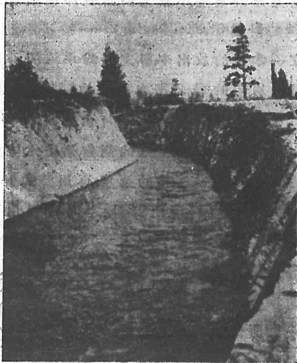
圖 140 未砌觀壁的陡岸運河.在內登達山脈 (Sierra Nevada Mts.) 中.
