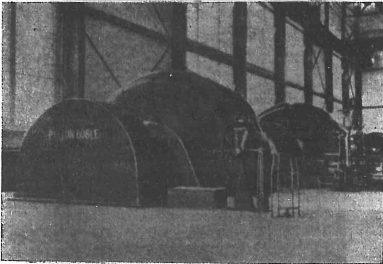
圖 207 在大西洋氣電公司之鼓機房內的柏爾屯衝動水輪。在靜止時， $h=1,375'$ ，在平常擔負時等於1,300； $N=360$ ； $H_p=8,500$  (每輪)。
