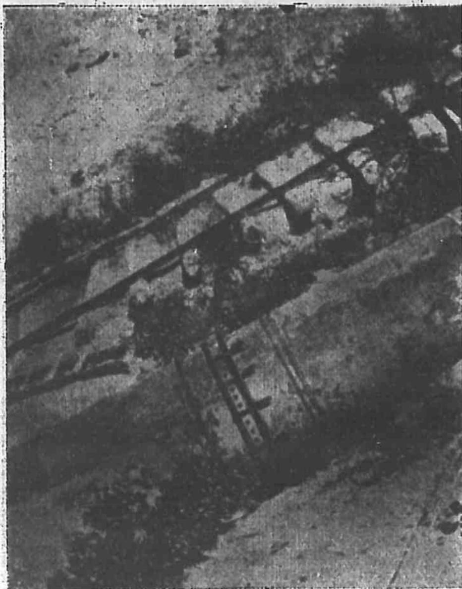
圖 129 在高壓鋼管內的伸縮接口
