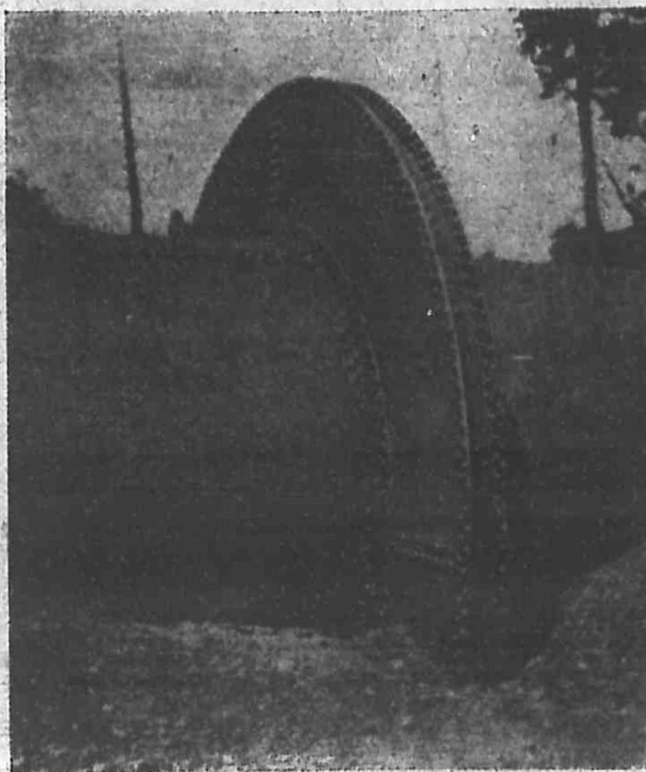
圖 128 在低水頭下, 8.5 呎鋼管的伸縮接口
