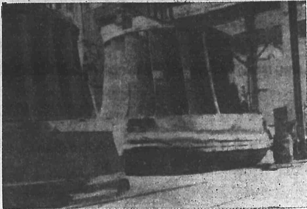
圖 186 世界最大輪機轉子之一。柯得瀨製造廠及動力公司所用。  $D=143'$ ;  $h=30'$ ;  $N=55.6$ ;  $Hp=10,800$ .
