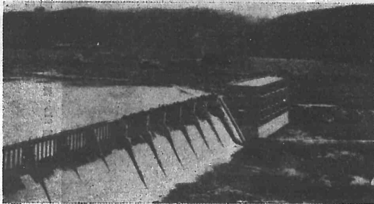
圖 213 亞伯拉索動力公司之第二水電工程，水頭=49呎，四個6,000馬力的輪機，各具116 r. p. m. 的速度。
