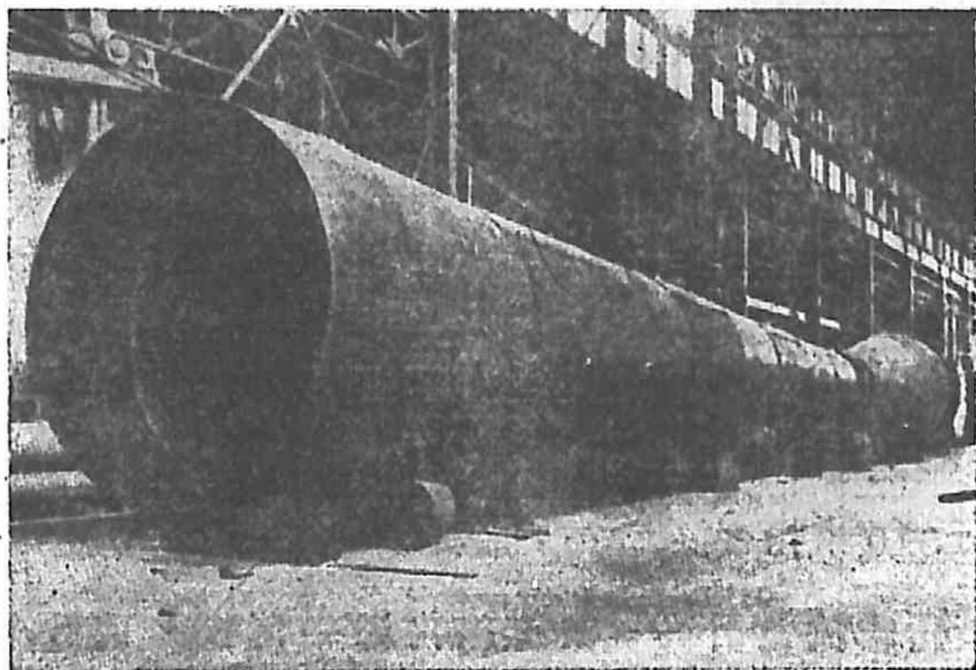
圖 82 鉚合鋼板的細腰流量計
