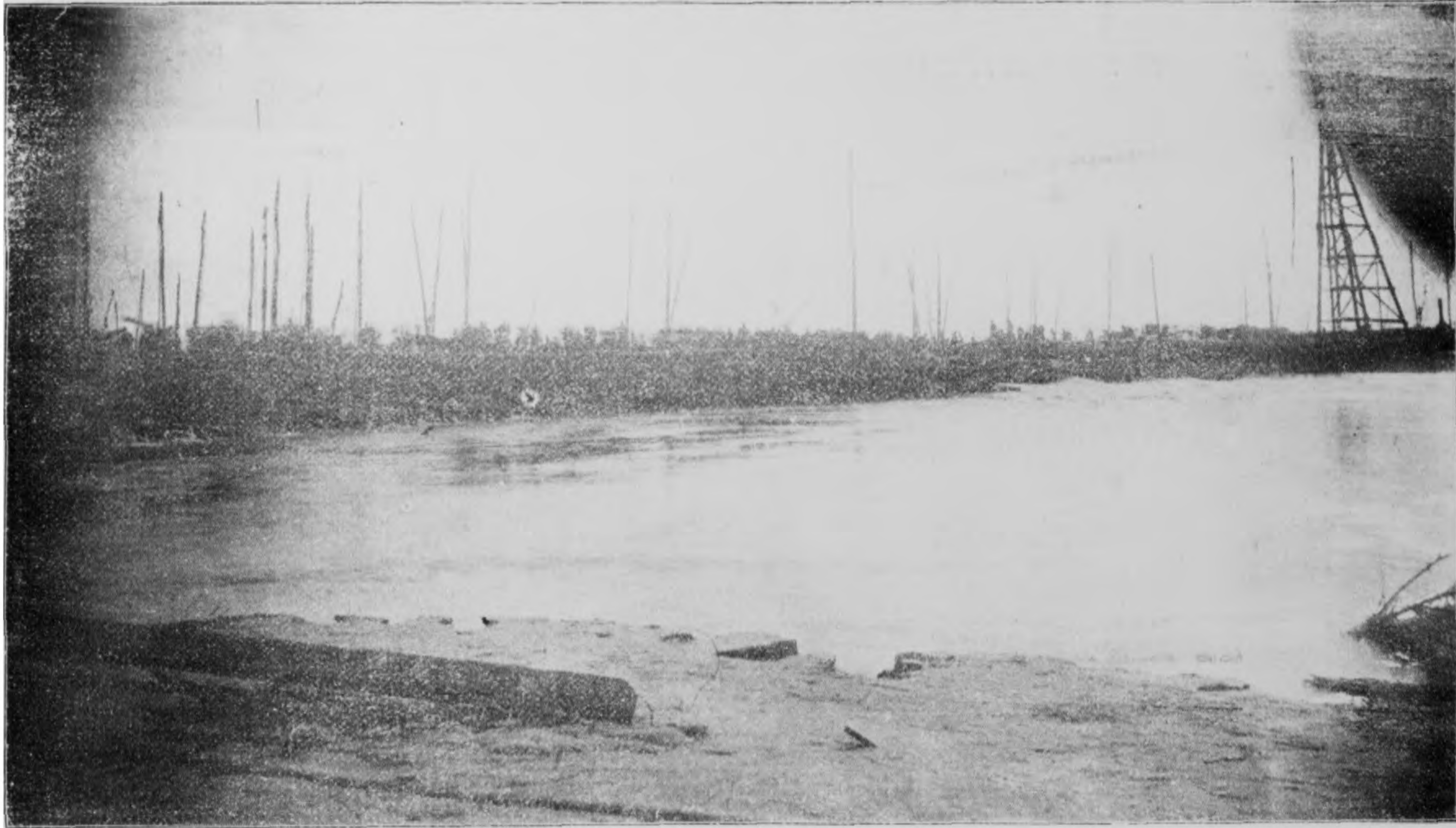
魏 廳 長 勒 查 馮 樓 塔 日 工 程 攝 影 之 二 此 係 塔 口 工 程 全 部 在 對 岸 所 攝
