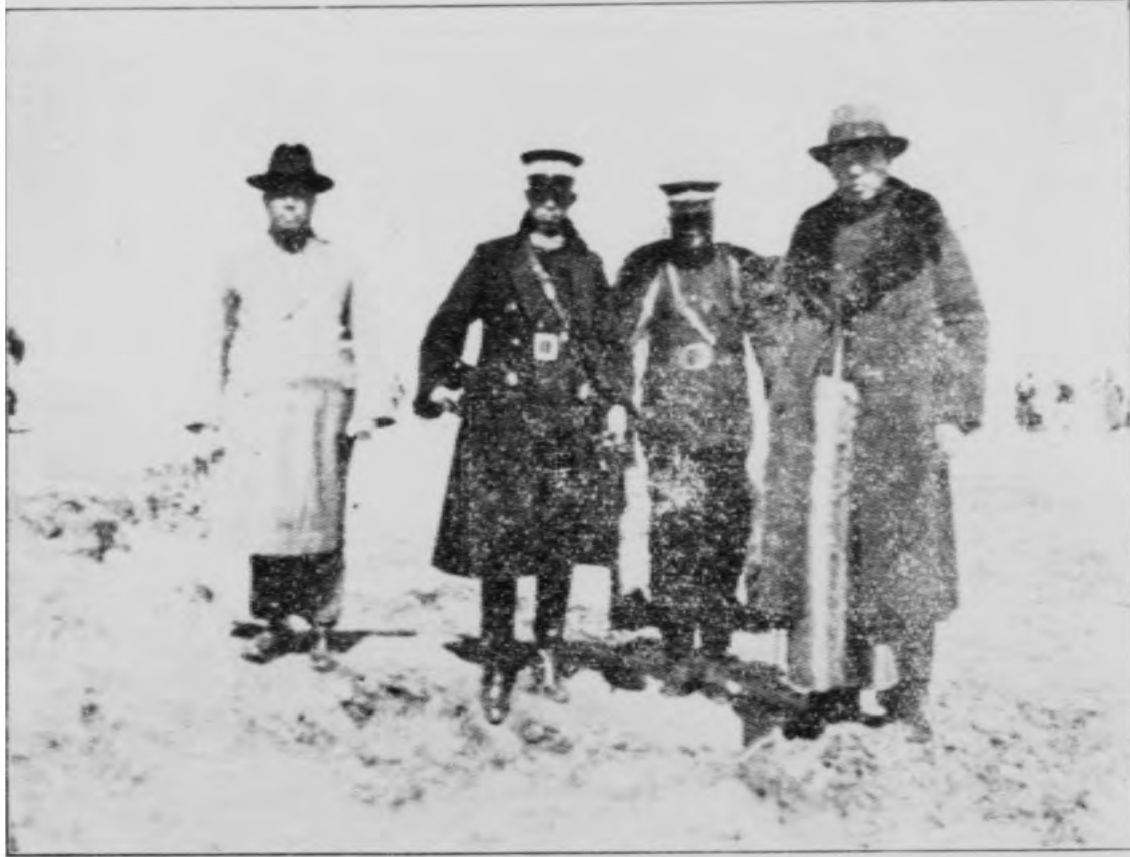
該堤已被厚沙淤平 不辨形跡內影 站立處即堤身也
