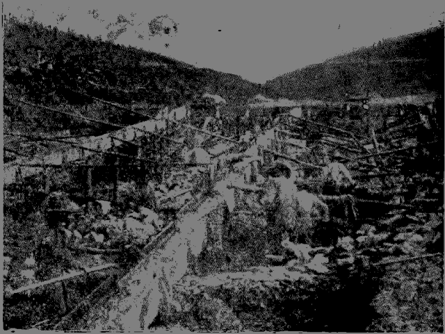
在水槽內從岩石和礫層中淘取金子
