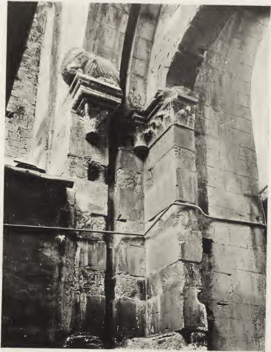
FORTEZZA — PARTICOLARE DELLA PORTA.
