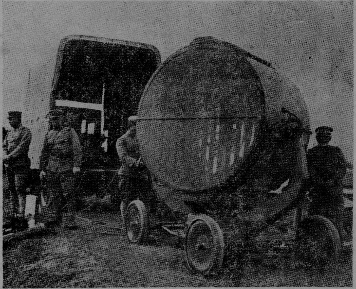
第十八圖 日空軍之防空探照燈（後部之車係發電力者）
