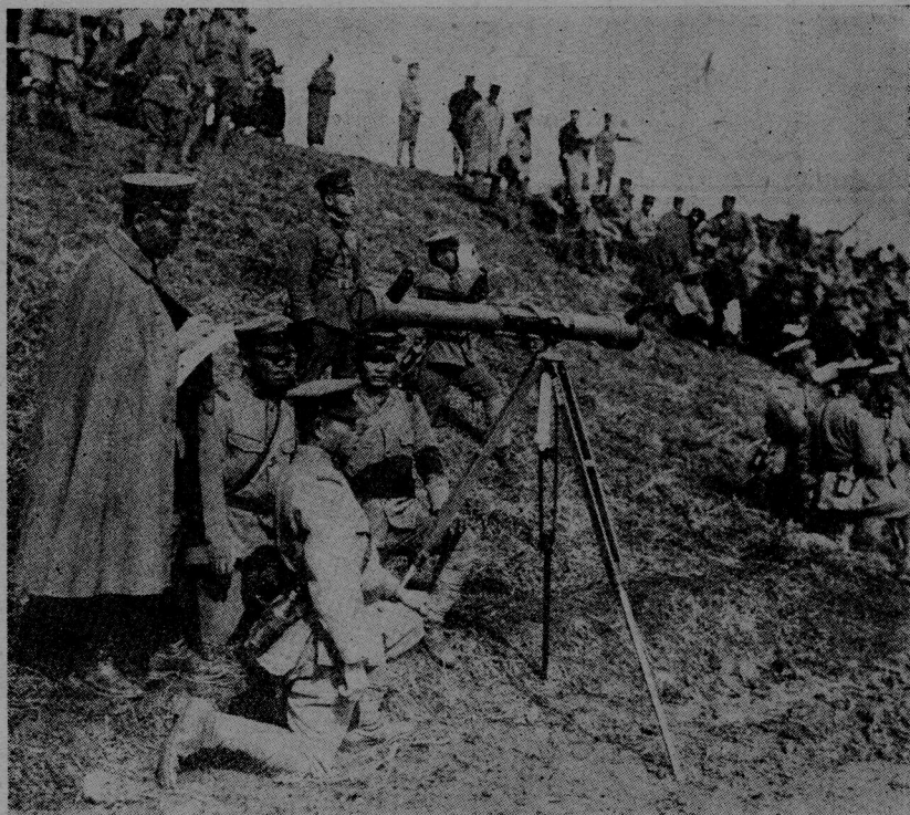
第七十八圖 日陸軍之高度測定機 (以之窺空中目標時可自動指示其高度及距離誠射擊飛機之利器也)
