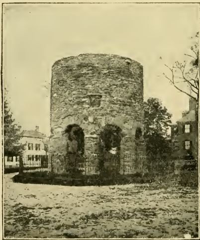
Old Stone Mill, Newport, R. I.
