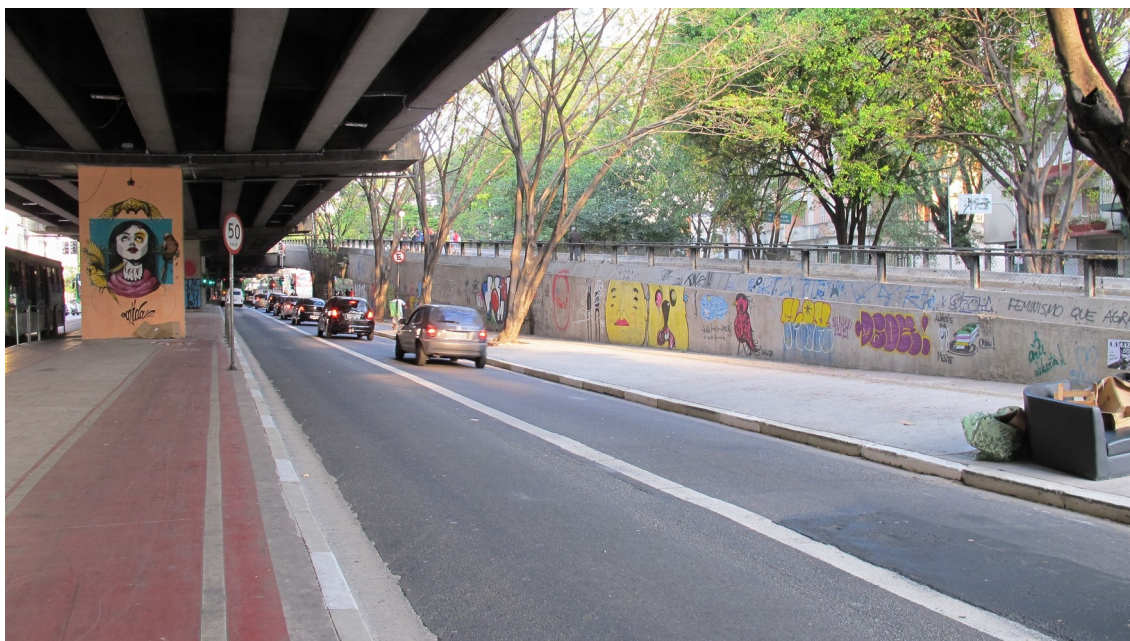
Baixios do Minhocão com graffiti e pixo nos pilares e rampa de acesso ao elevador. Foto: Alice Torres, 2016.
