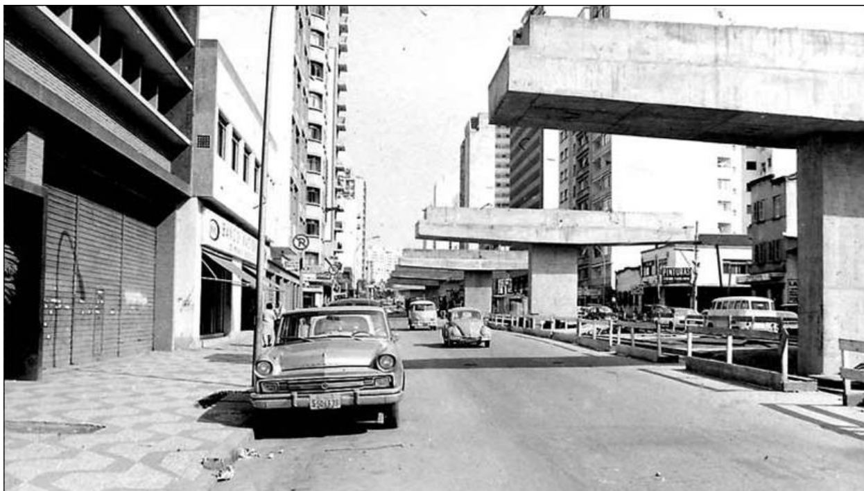
Situação de proximidade do elevado, em construção, com as edificações do entorno, em 1970. Fonte: Arquivo da PMSP. In: Assunção, 2016, p. 122.
