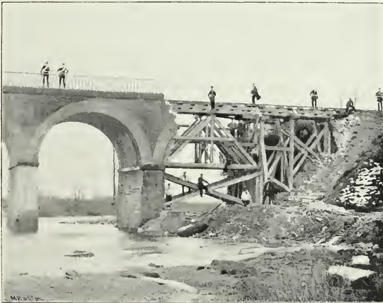
Dgnon-Brücke bei Lure.
