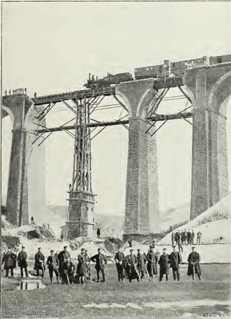
Viadukt bei Fertigm.
