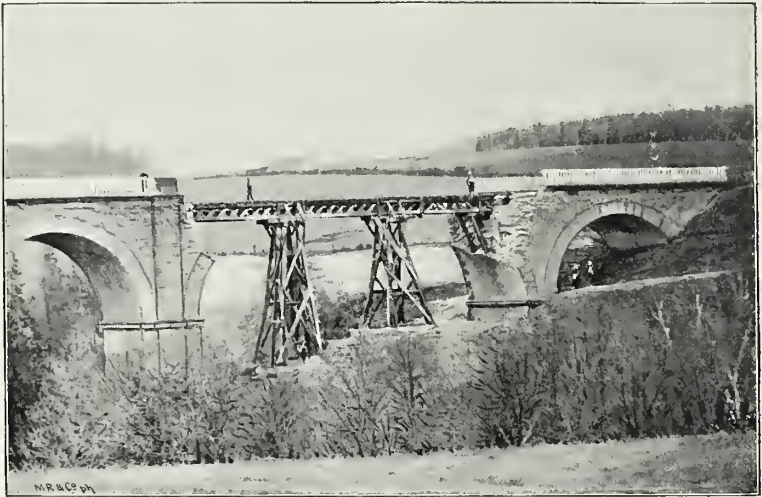
Viadukt bei Epinal.
