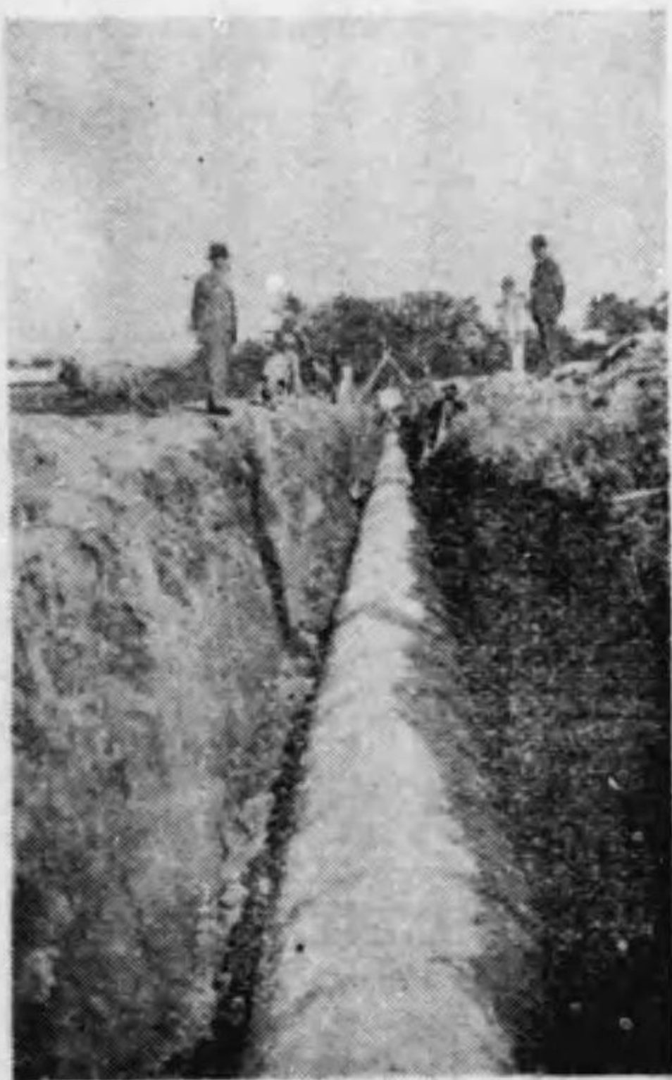
瀧子水路排水管埋設工事中の景
