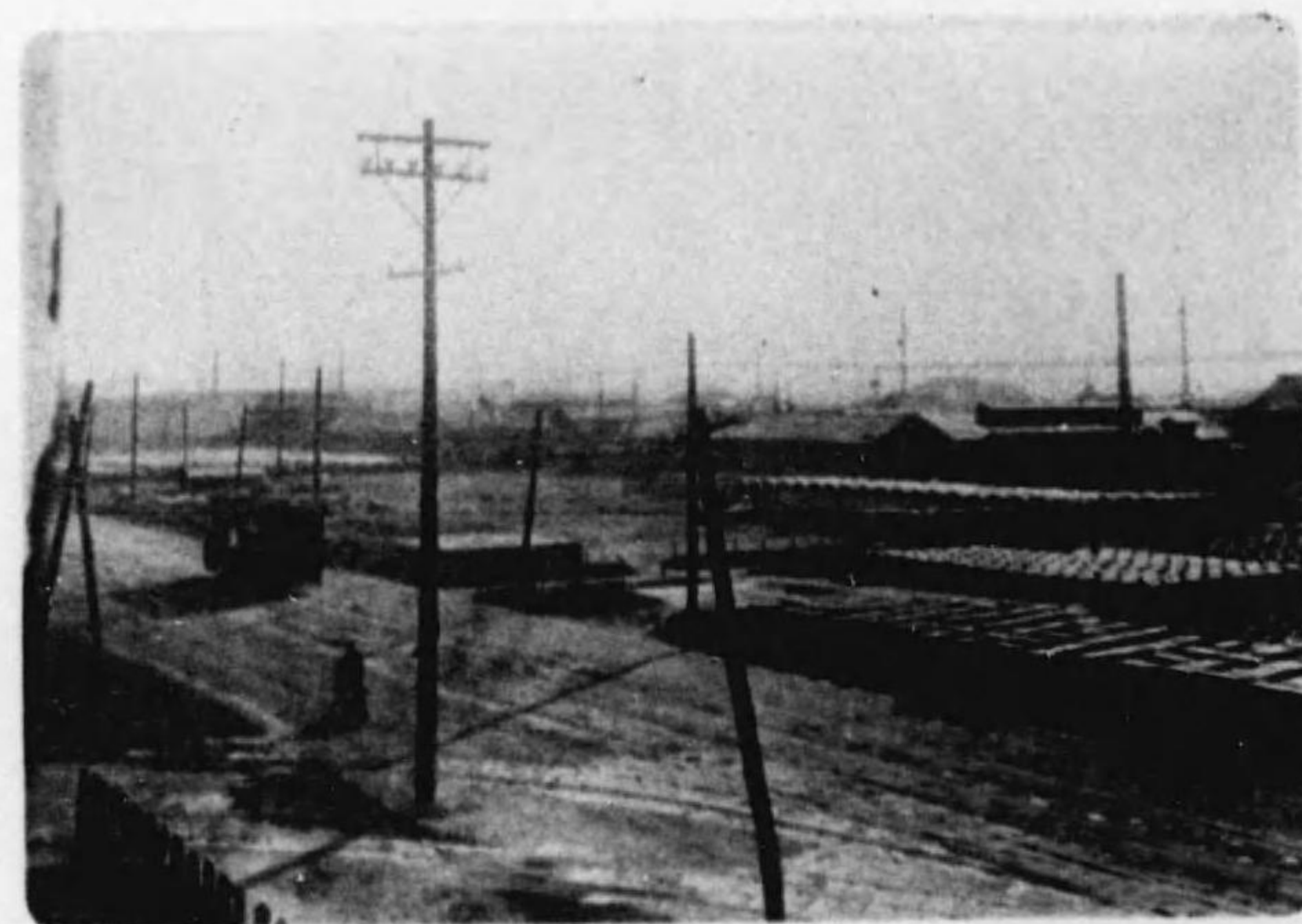
第一區高辻電車停留所附近ノ工場地帯
