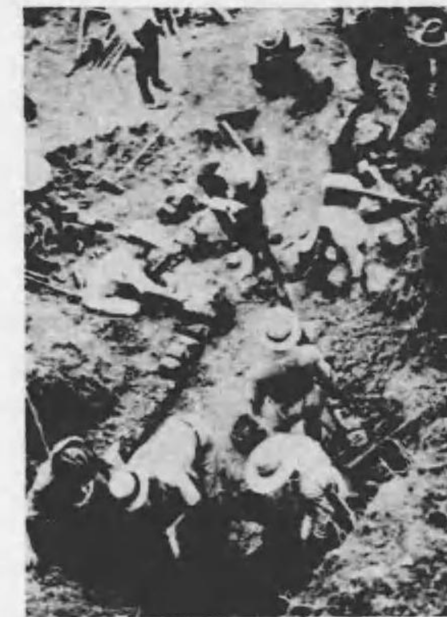
第3圖 窯壁構築開始(備長式)
