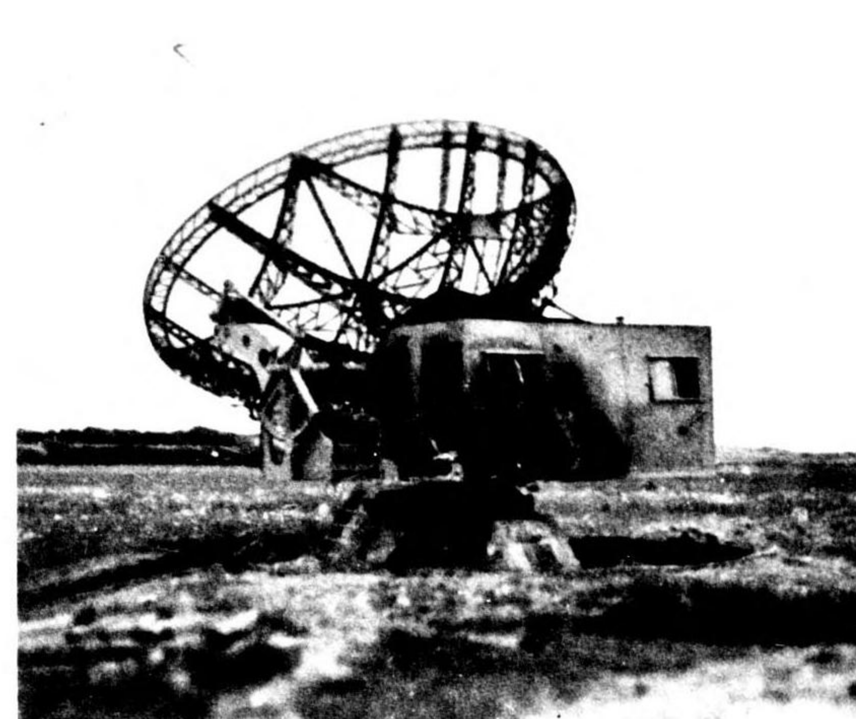
GIANT WURZBURG - REAR VIEW
