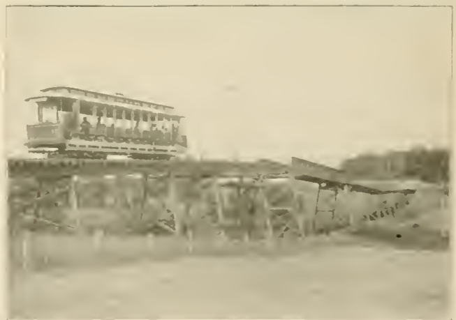
WEST SIDE R. R. TRESTLE.
