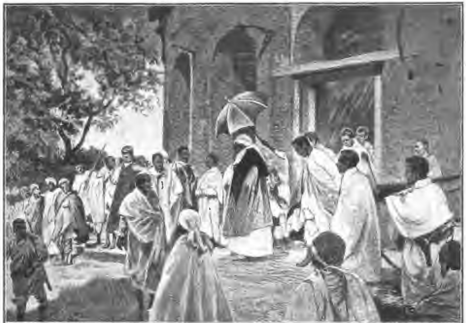
Негусъ Менелинъ II осматриваетъ работы по постройкѣ церкви. По рис. III. авторгилія „Нива“.
