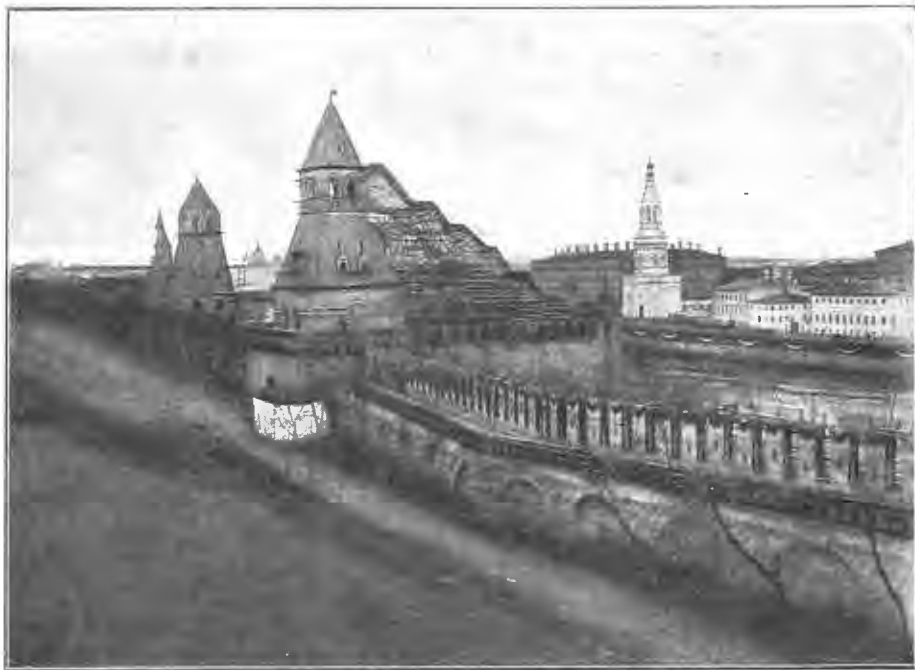
Коронаціонныя торжества въ Москвѣ. Тайничная башня въ Кремлѣ съ лѣсами и приспособленіями для подъема воды на верхъ изъ Москвы-рѣки. Вода эта каскадомъ будетъ пущена съ верху башни и освѣщена разноцвѣтными огнями во время иллюминаціи.
