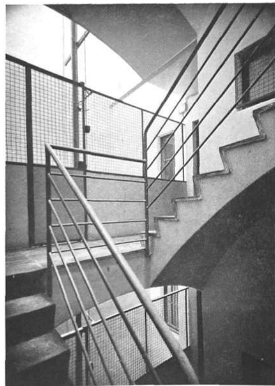
Viviendas de alquiler Calle Rosellón, Barcelona. Detalle escalera.
