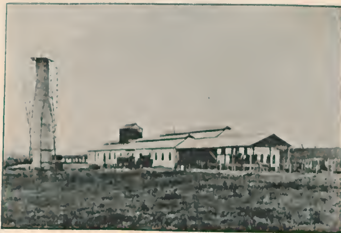
Usina Trezeiros — Escada, Pernambuco
