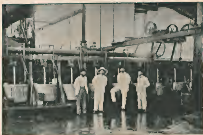
Engenho Central Itacolumê (Sergipe) — Turbinas
