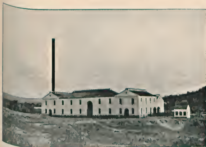
Usina Terra Nova (Bahia)—Vista geral
