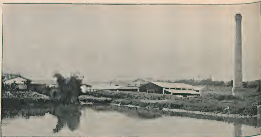
Usina S. Bento (Bahia) — Reservatório d'água
