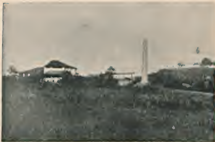
Usinas Trapiche do Cabo — Cabo (Pernambuco)
