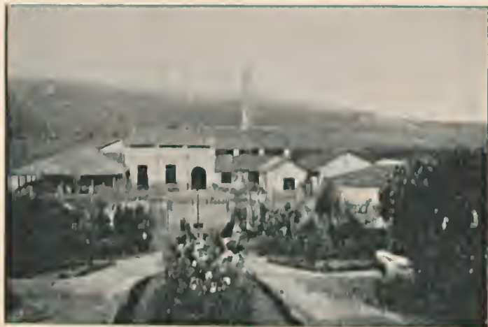
Usina Brazilleto, de F. A. G. Vandermiet, Atalala, (Alagoas)
