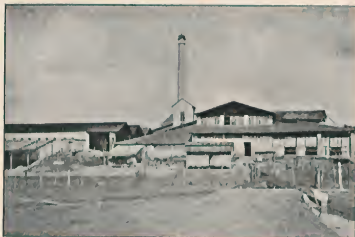
Usina Allouca (Bahia) - Vista geral
