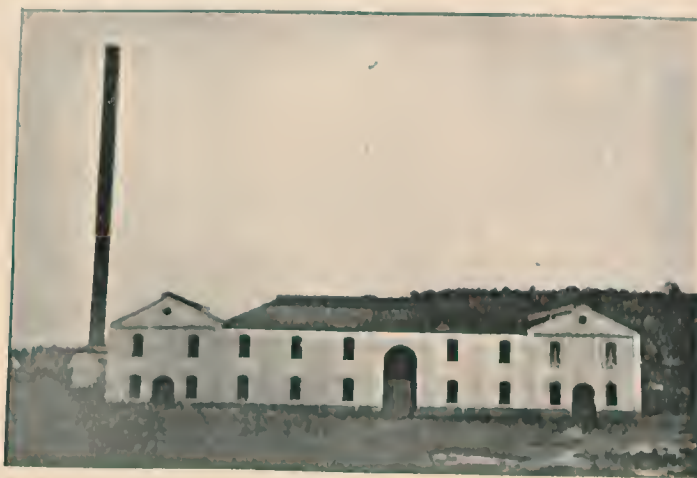
Usina Terra Nova (Bahia)—Vista de fundo
