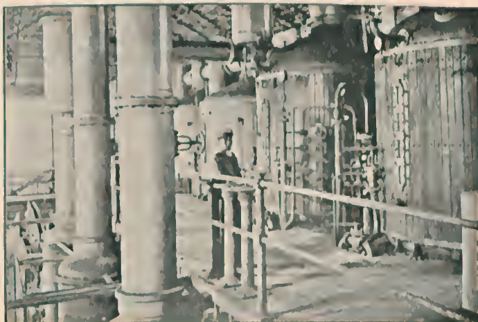
Usina Terra Nova (Bahia)—Condensadores, vences e triplice effeito
