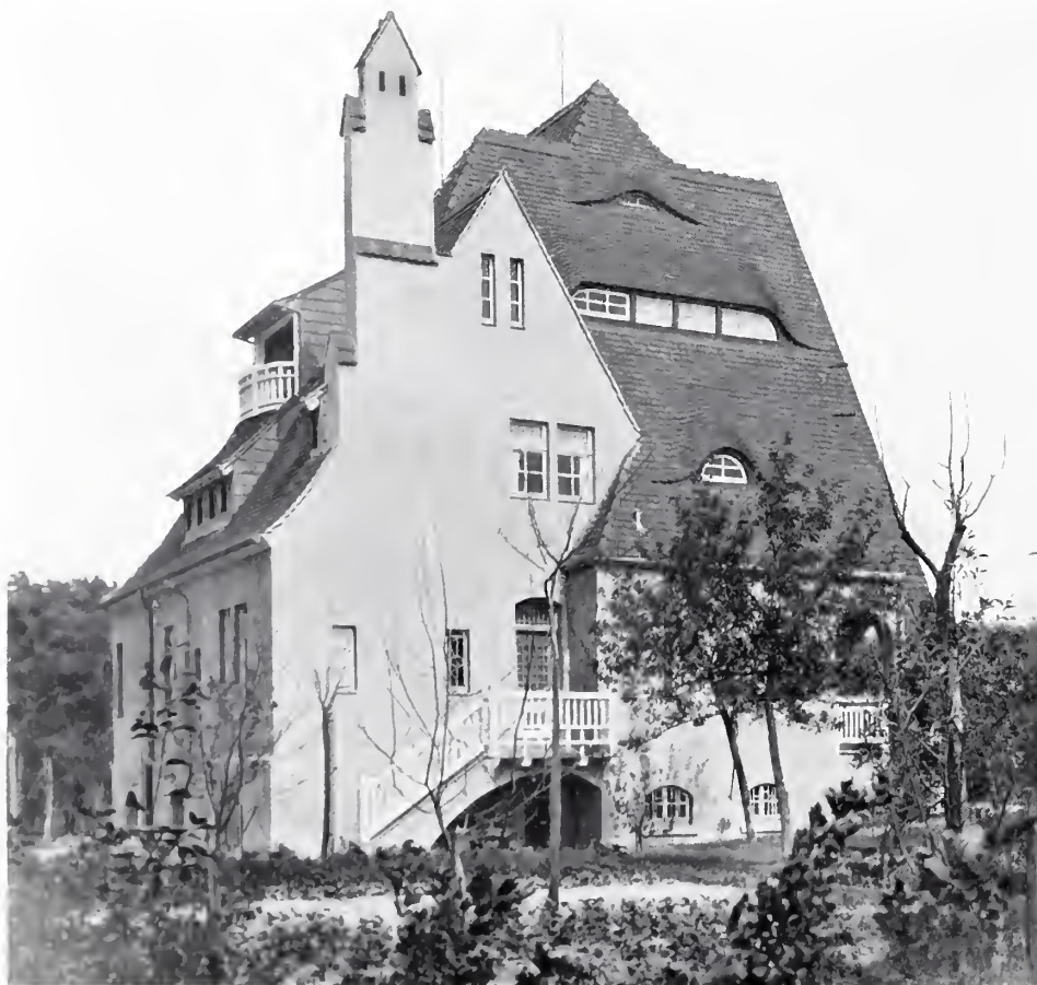
Ansicht von Südwesten. Wirtschaftseingang
