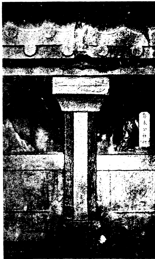
柱石角八祠巨郭山堂孝(乙)
