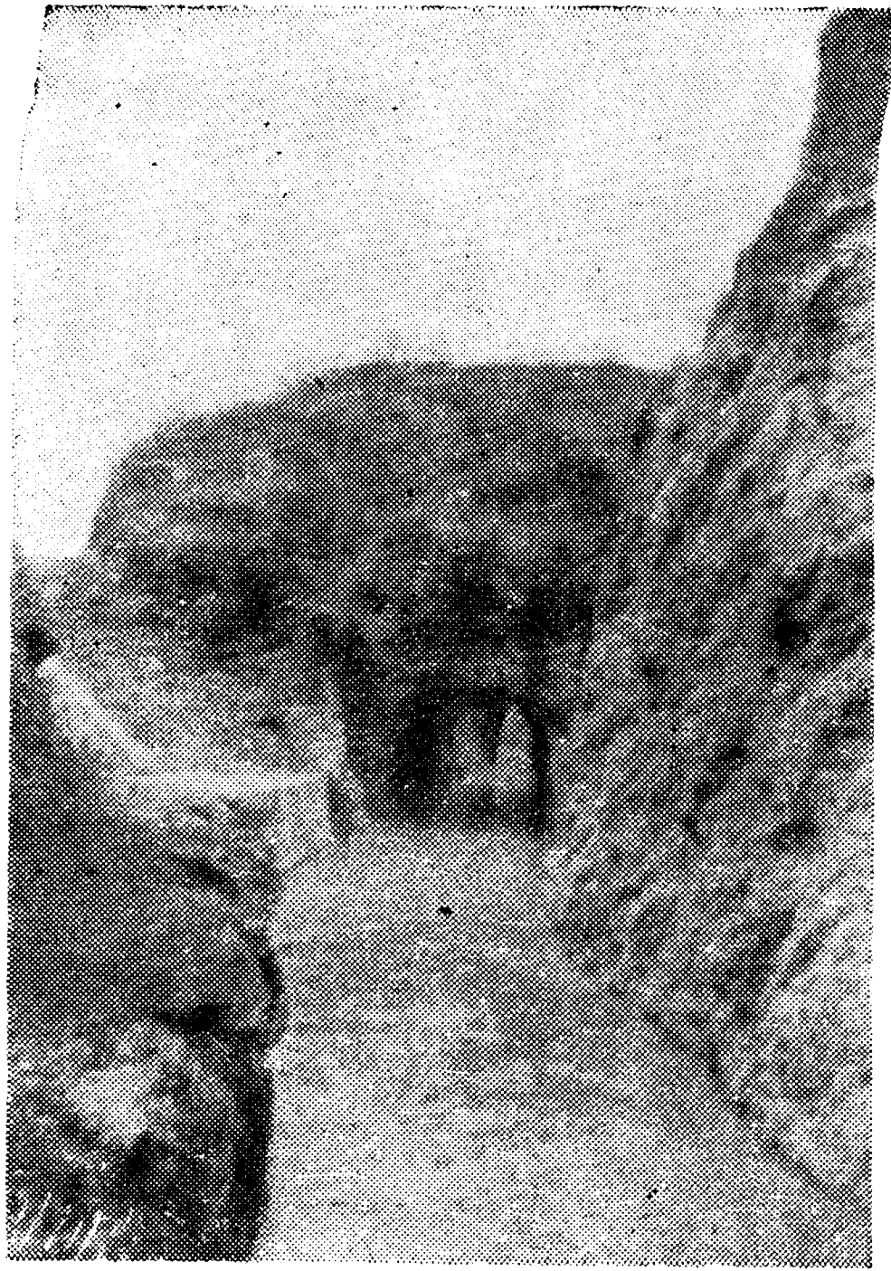
惠水連江灌溉區永水渠山洞
