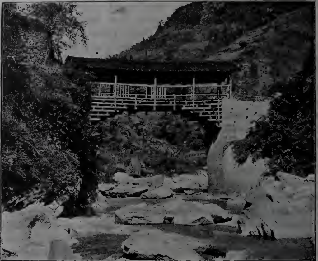
Holzbrücke mit Dach, Hupeh.
