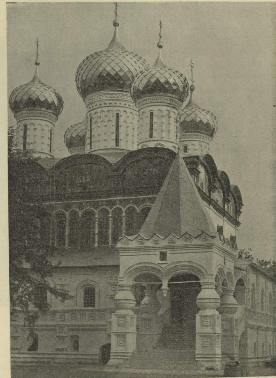
Общій видъ Троицкаго собора съ сѣверо-восточнаго угла, послѣ реставраціи.
