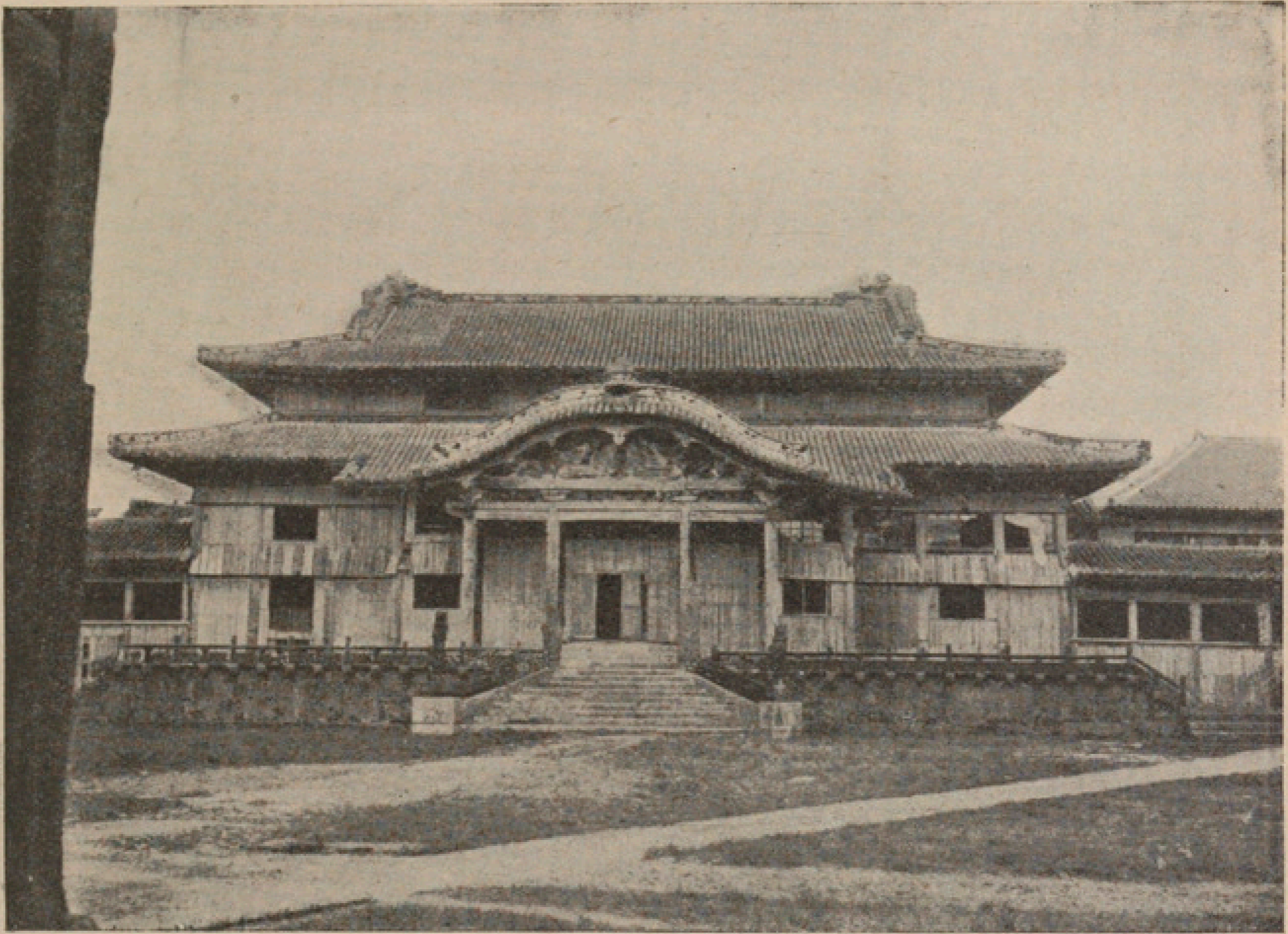
L'ancien palais des Rois à Shuri.
