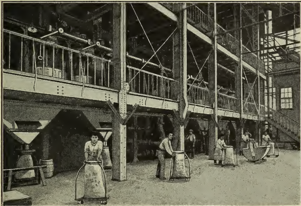
MILL INTERIOR—BAGGING SUGAR.
