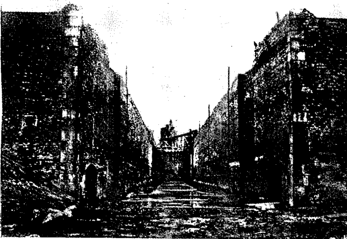
Рис. 2. Шлюзъ канала Берлинъ—Штеттинъ.
