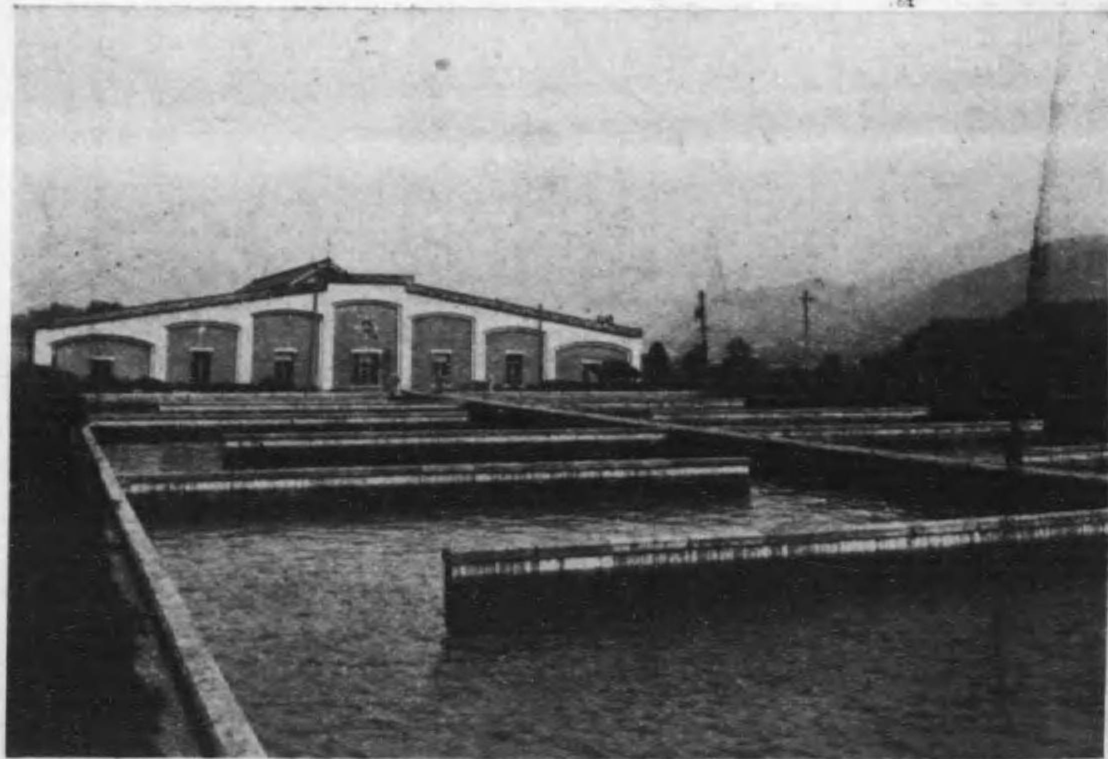
既上淨水場沈澱池
