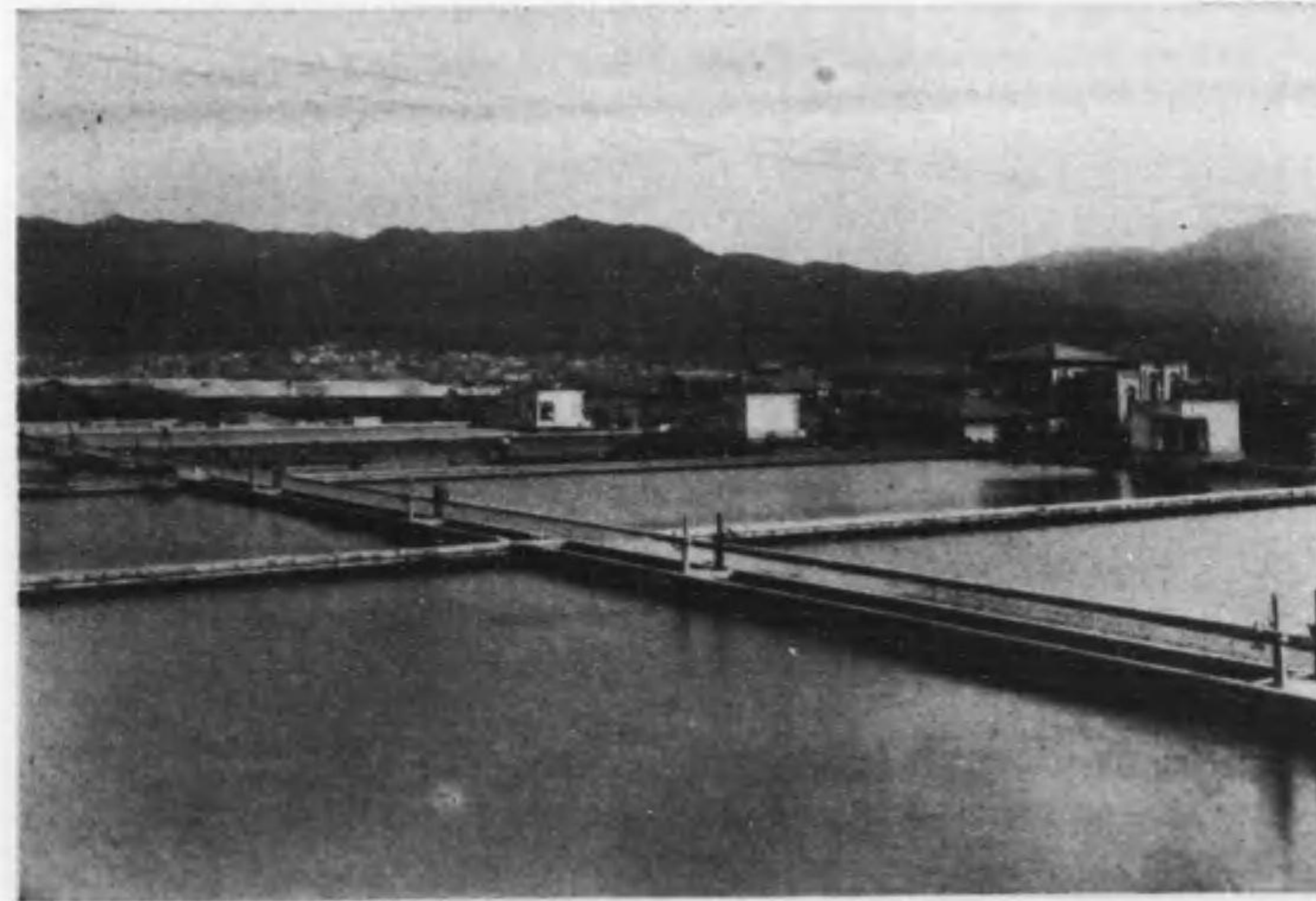
池過濾場水淨崎ヶ松
