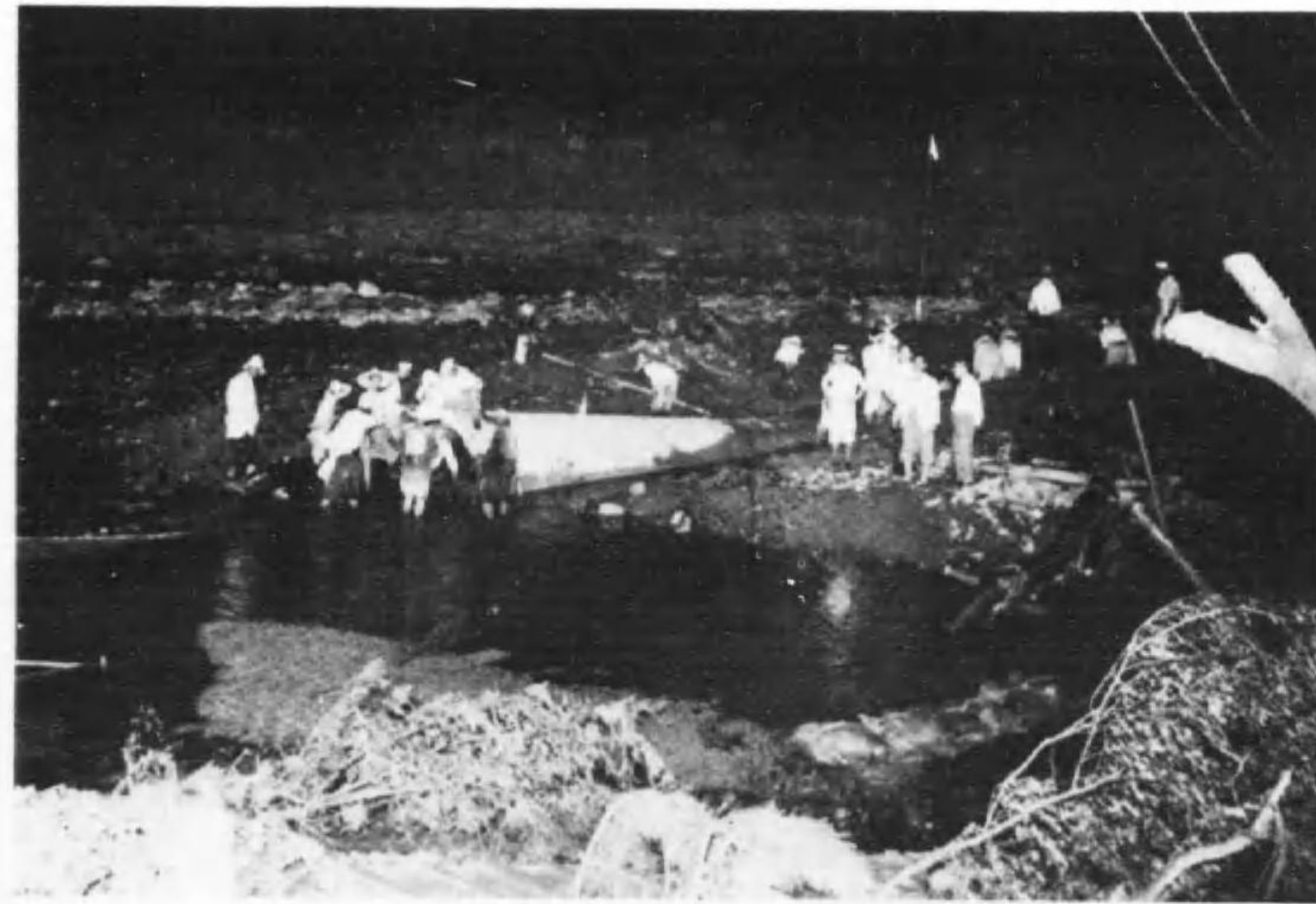
水害時松崎ノ導水管復舊夜間作業
