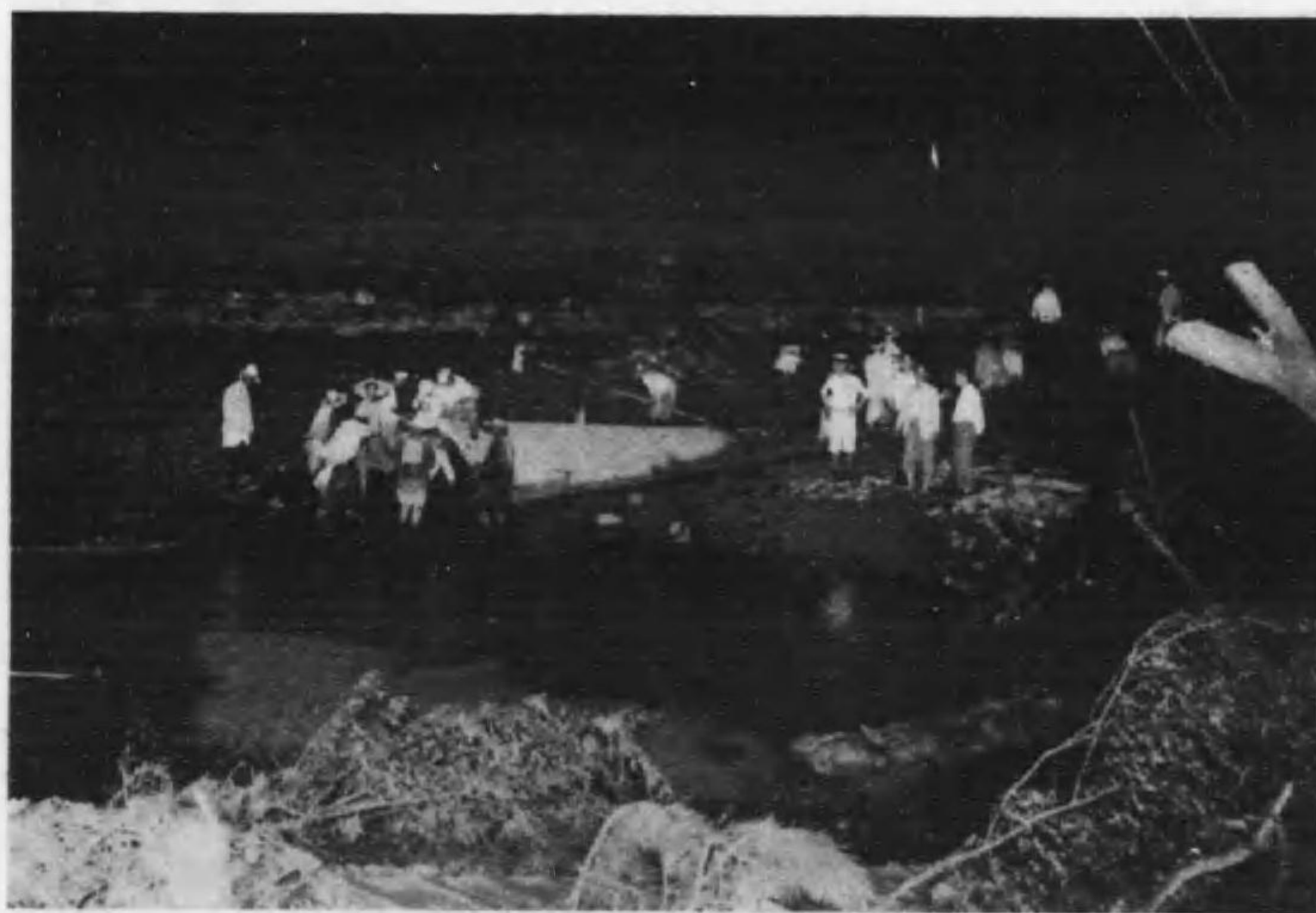
水害時松崎導水管復舊夜間作業
