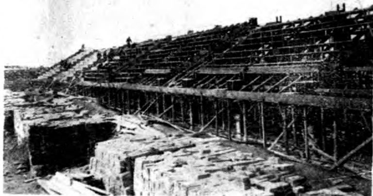
看臺外部之建設
