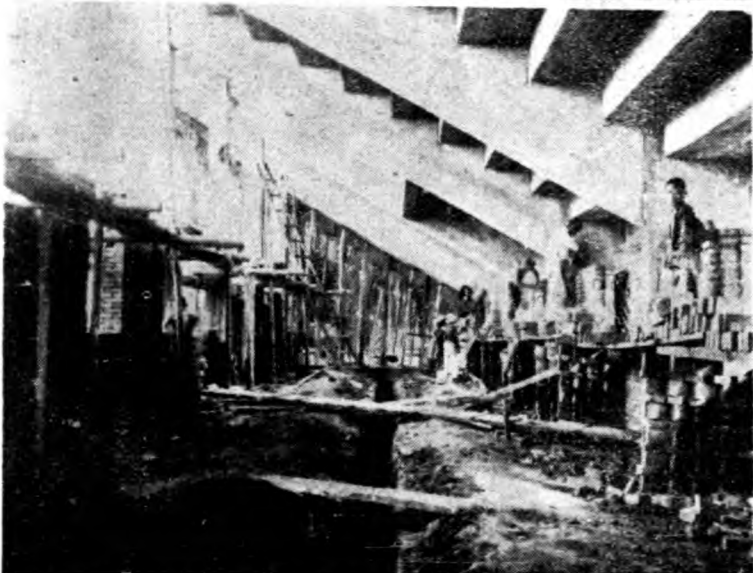
看臺內部之建設
