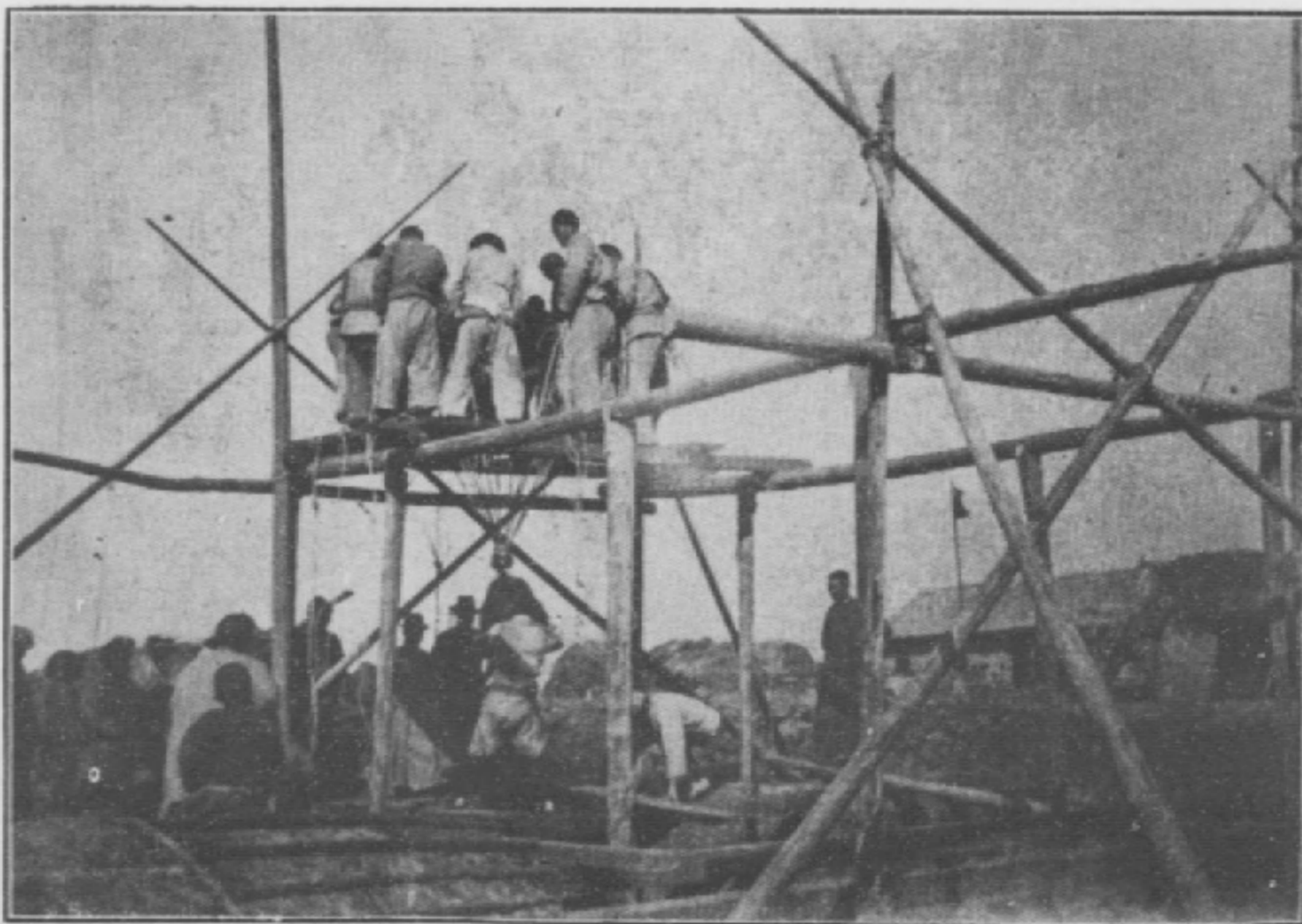
形情之樁打礎基開水築建場驗實湖山龐
