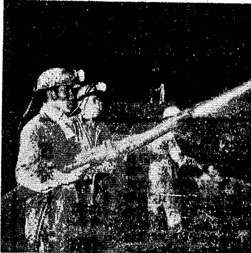
青山矿井的工人，遵照毛主席关于“自力更生”、“艰苦奋斗”的教导，自己设计、自己制造设备。这是他们用自制的“新型混凝土喷射机”给井壁喷浆时的情景。（本报记者摄）
