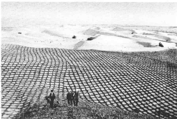
◎在退牧还草、生态移民等措施的作用下，宁夏沙漠化土地由退牧还草前的1.65万公顷，减少到目前的1.18万公顷。图为2007年宁夏灵武市白芨滩林场职工在扎草方格治沙。
