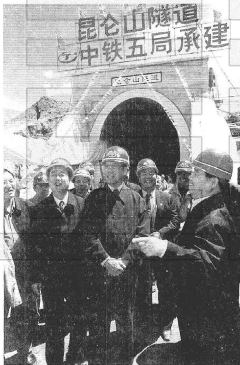
©2002年6月29日，考察昆仑山隧道建设工地。
