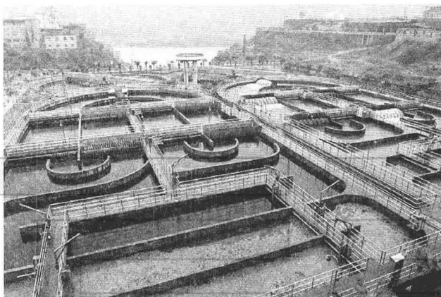
◎重庆市万州区加快污水处理厂建设步伐，为保长江水质。 图为三峡库区万州明镜滩污水处理厂，该厂处理后的污水 排放标准达到国家一级。
