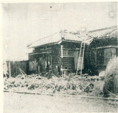
↑ 民權路警察局宿舍圍牆吹倒 屋頂損壞
