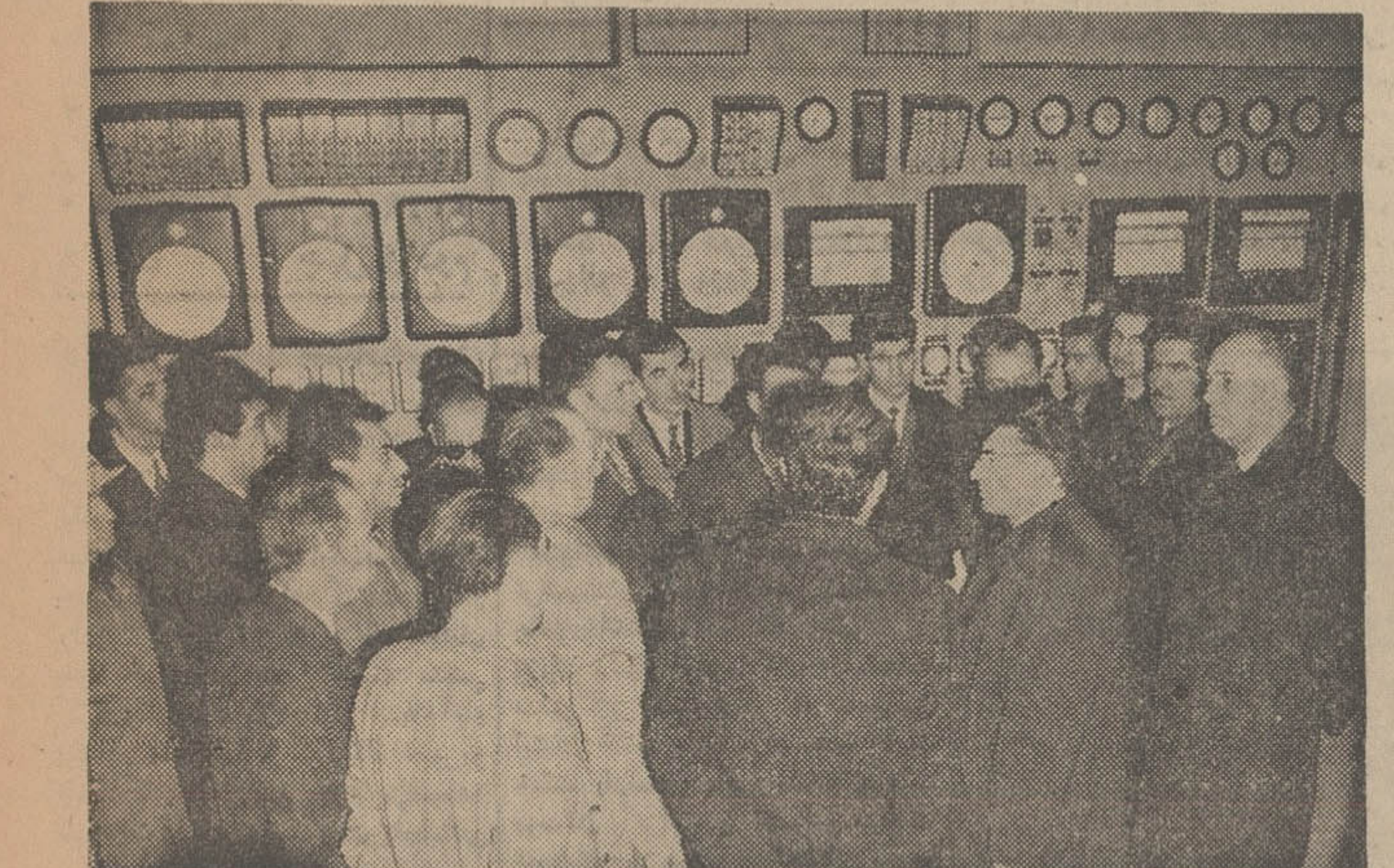
از برابر تابلو کنترل خودکار، کارخانه برق فرح آباد باز دید کنندگان و مدیران کارخانه هنگام دادن توضیحات دیده میشوند.
